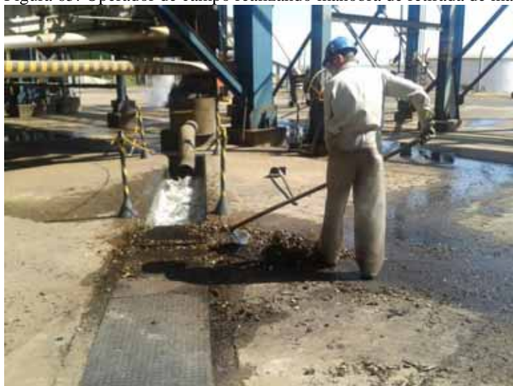
Figura 65: Operador de campo realizando manobra de retirada de materiais não queimados
