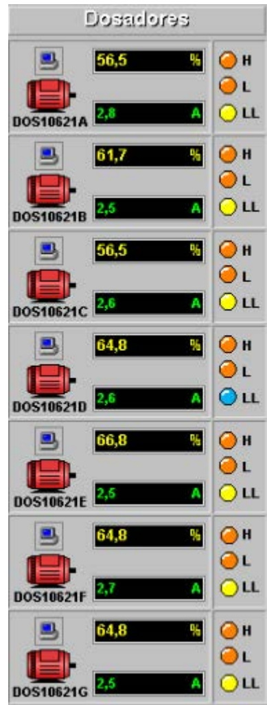
Figura 44: Dosadores de biomassa (combustível: 50% cavaco 50% bagaço), imagem do supervisório
