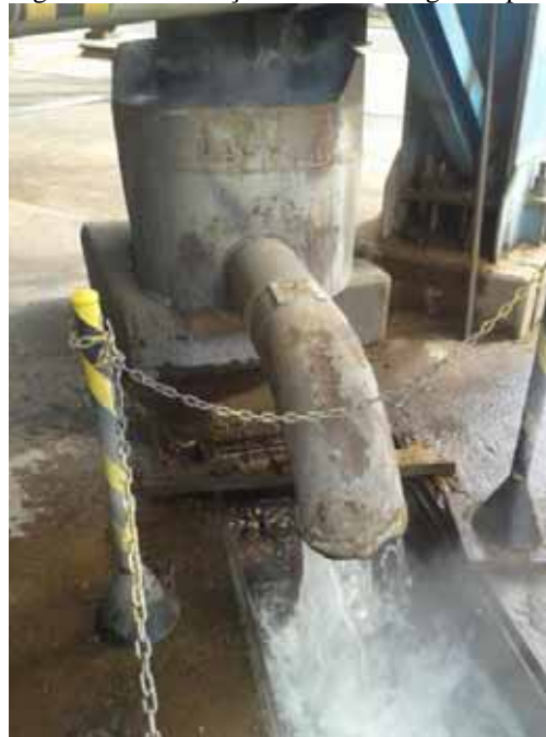
Figura 67: Eliminação de cinzas da grelha por via úmida.
