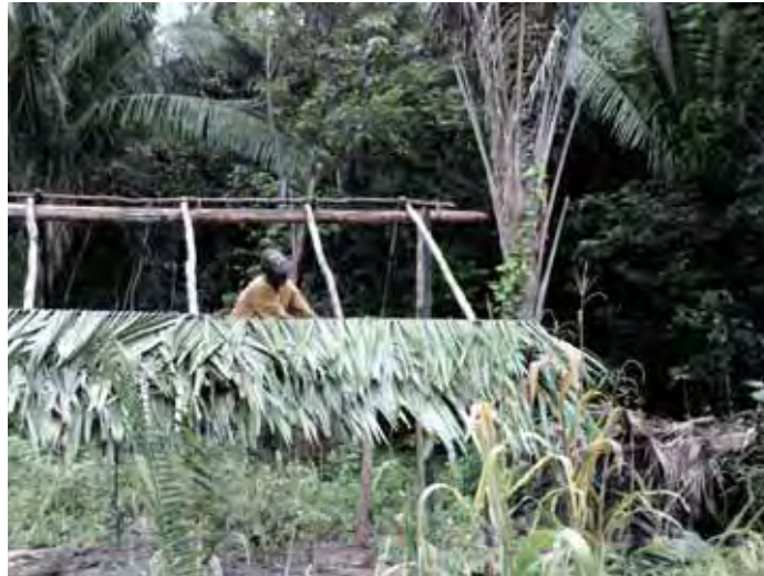
FIGURA 13 – COBERTURA DA CASA
