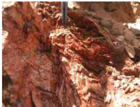
Fig. 3.7 - Afloramento de chão em canaleta de estrada de terra.
