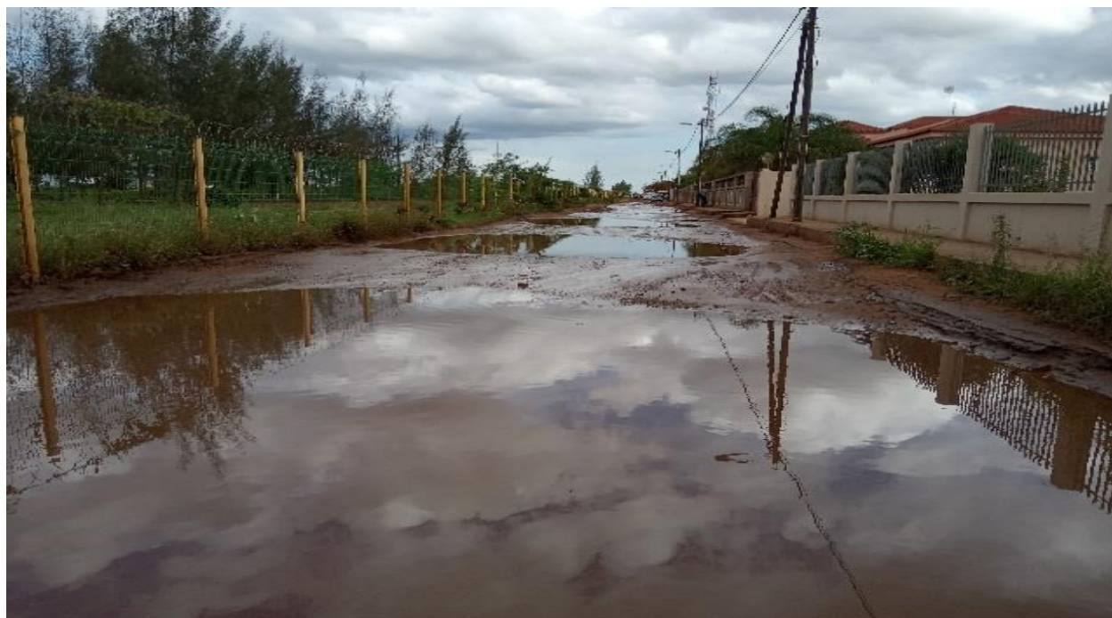
Foto 4. Vista parcial de rua em Tchumene I
