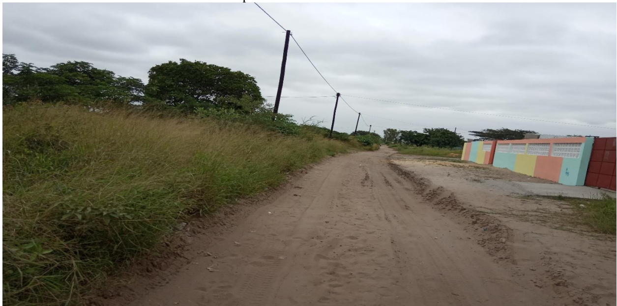
Foto 14. Vista parcial de uma rua no bairro Mucatine
