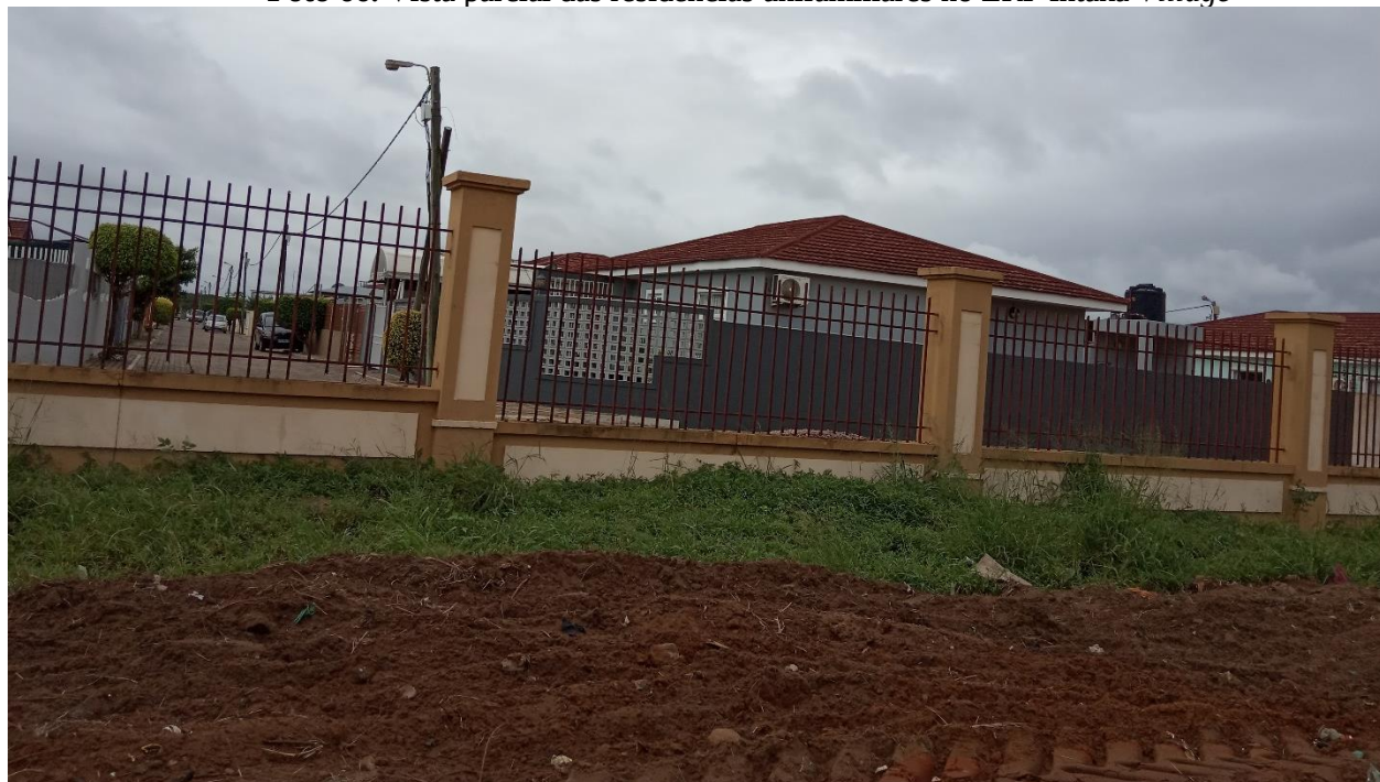
Foto 66. Vista parcial das residências unifamiliares no ERF Intaka Village
