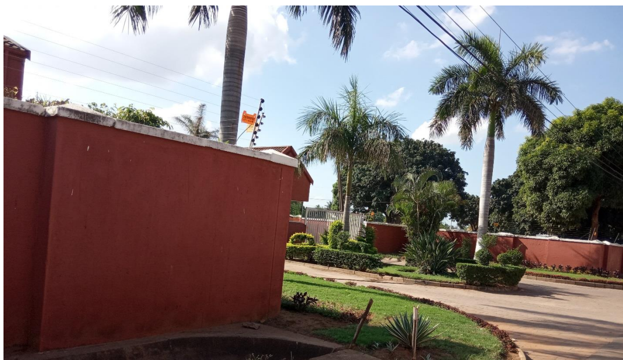
Foto 59. Vista parcial da entrada do ERF do PETROMOC
