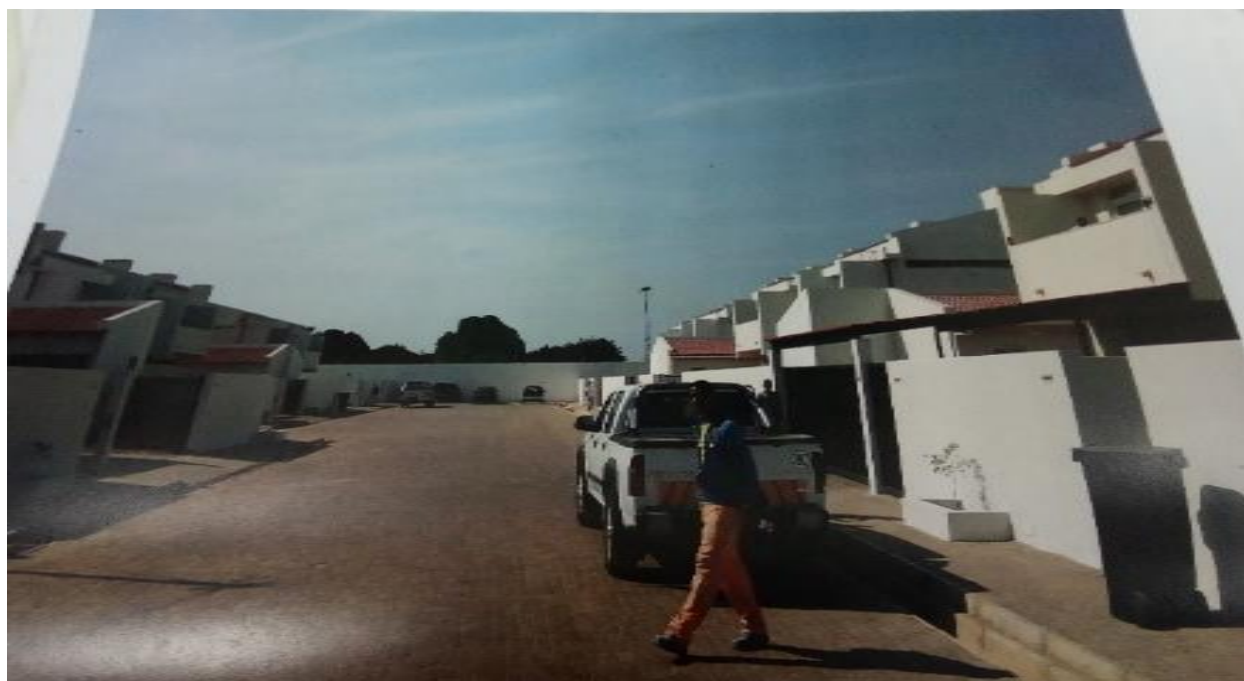
Foto 61. Vista parcial da parte interna do ERF Vila Sara
