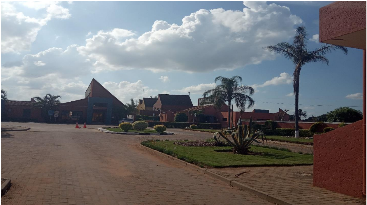
Foto 60. Vista parcial da parte interna do ERF do PETROMOC
