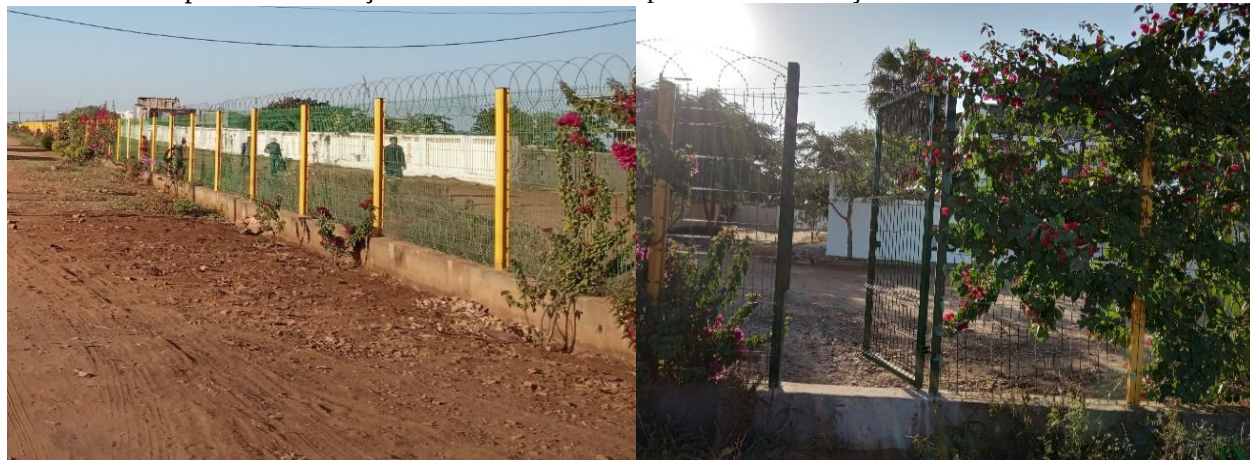
Foto 71. Vista parcial da vedação e entrada e saída de peões na Associação dos Moradores do Tchumene I
