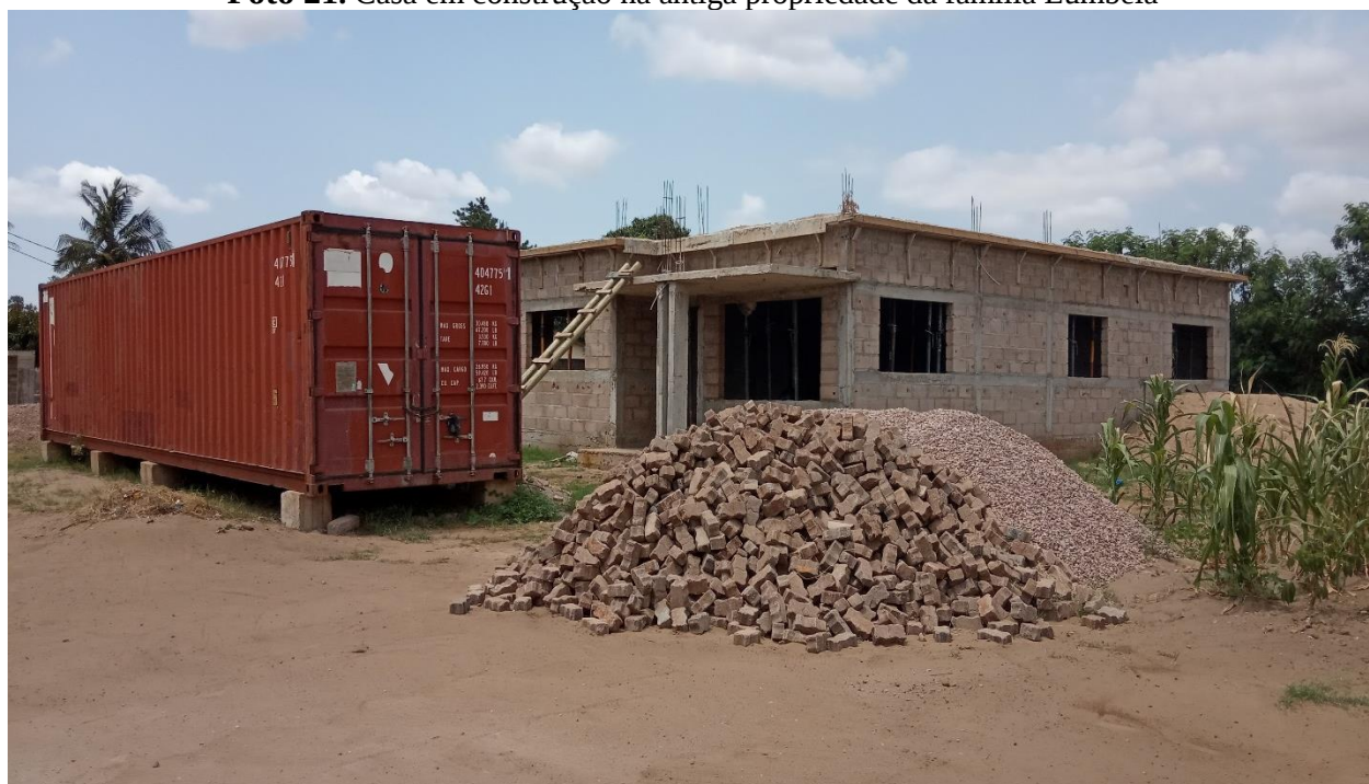
Foto 21. Casa em construção na antiga propriedade da família Lumbela
