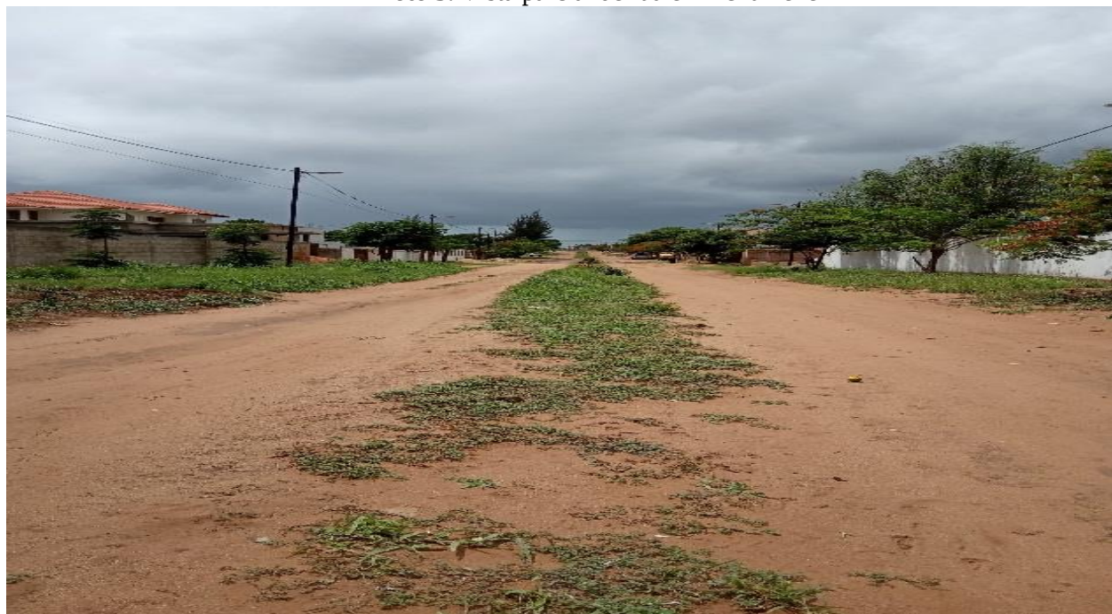
Foto 5. Vista parcial de rua em Tchumene I
