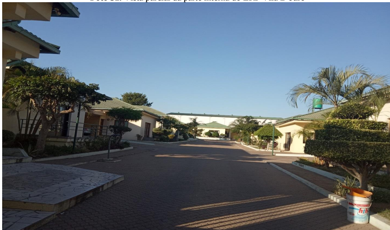
Foto 32. Vista parcial da parte interna do ERF Vila D'ouro
