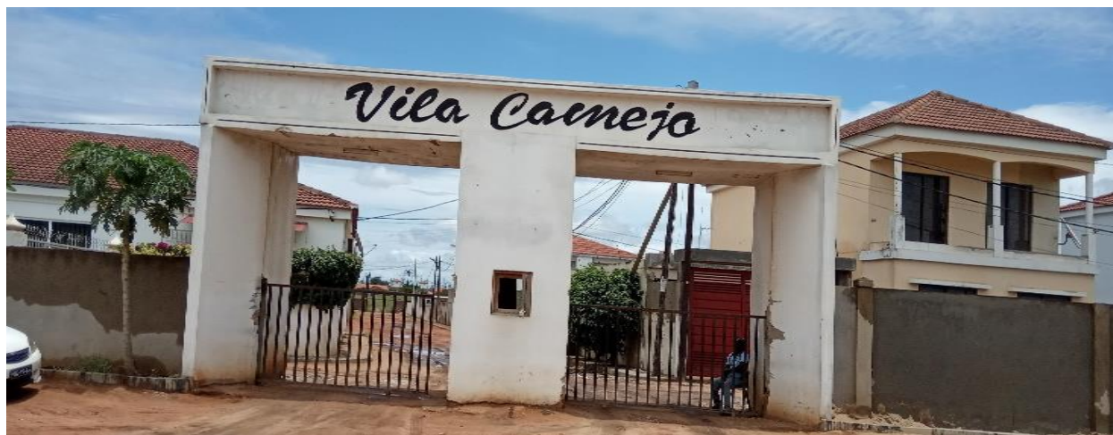
Foto 24. Entrada do ERF Vila Camejo
