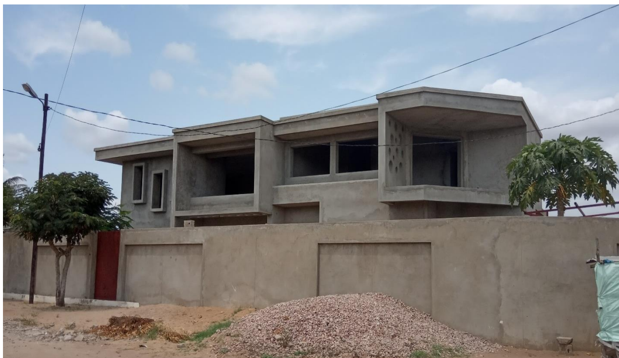
Foto 22. Casa em construção na antiga propriedade da família Lumbela
