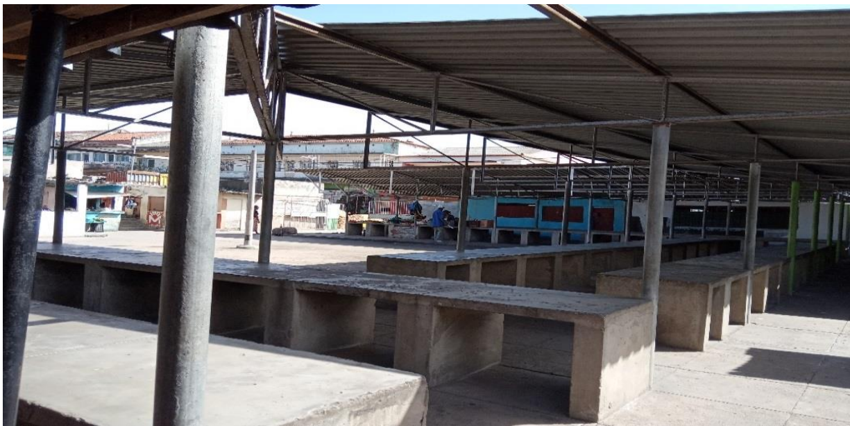
Foto 11. Vista parcial das barracas construídas pelo município no mercado municipal do bairro Infulene A
