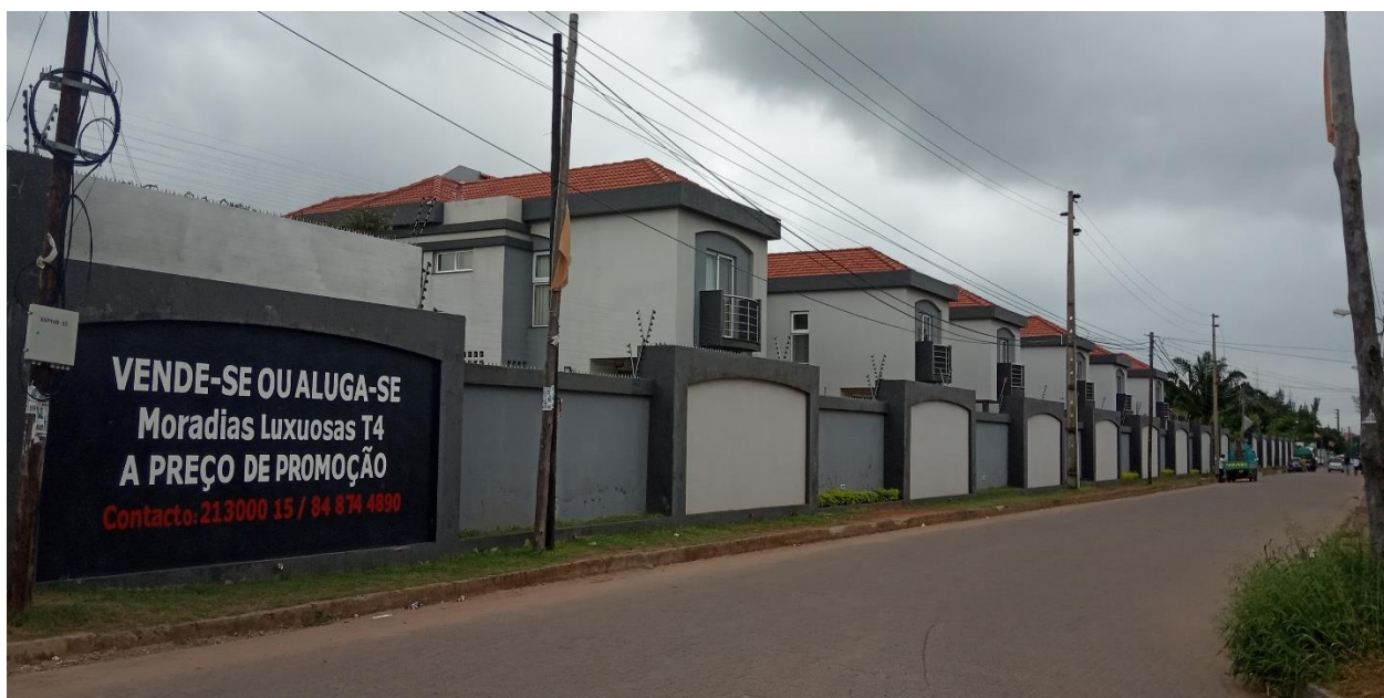
Foto 53. Vista parcial da parte frontal do ERF Matola Housing
