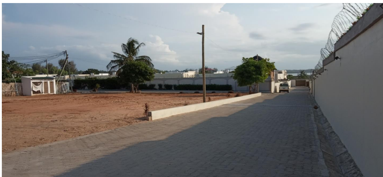
Foto 50. Vista parcial da parte interna do ERF Vila das Famílias nos talhões 34 e 36/2
