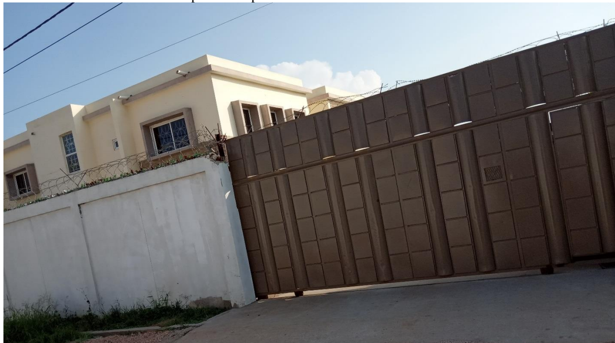
Foto 51. Vista parcial da parte frontal do ERF Vila das Famílias no talhão nº 35
