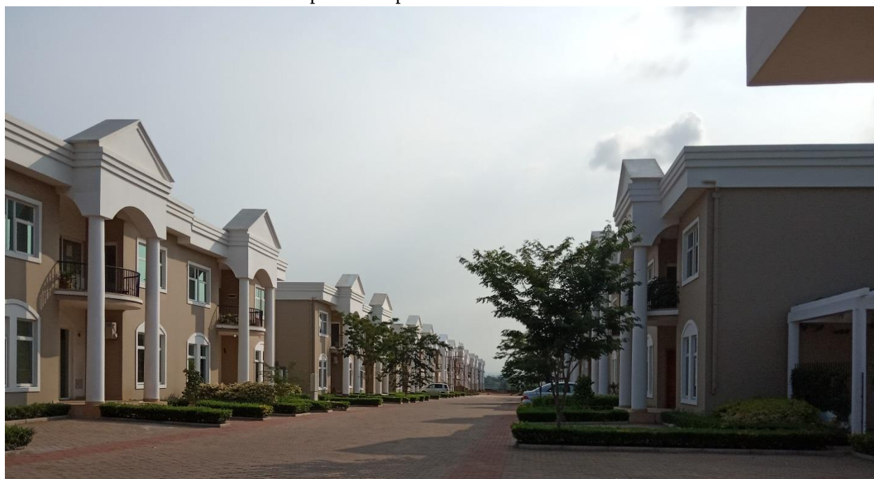
Foto 46. Vista parcial da parte interna do ERF Elite Residence
