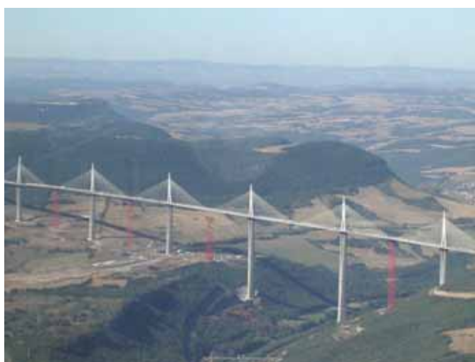
Figura 4 - Viaduto de Millau
