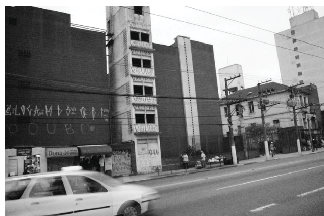
Figura 15 - Edifício Celso Garcia
