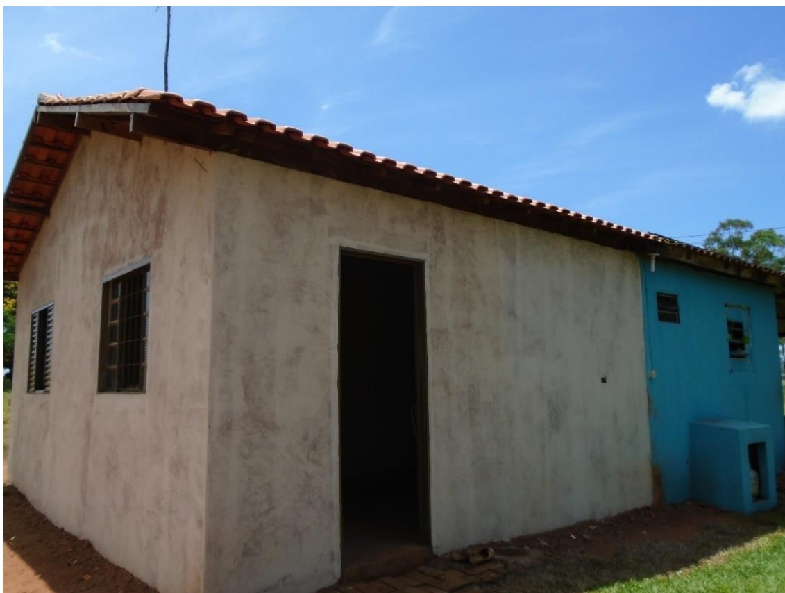
Figura 25 - Foto da construção da cozinha da entrevistada Dona Angélica com recursos obtidos com a comercialização de produtos no PAA.
