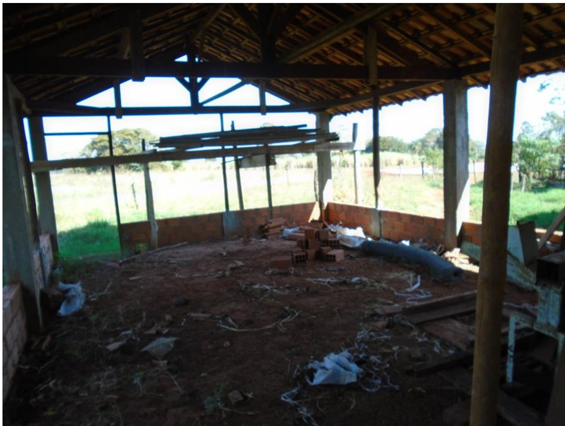
Figura 30 - Barracão no lote da Dona Lilian e do Senhor Celestino, sendo construído para a criação do frango caipira.
