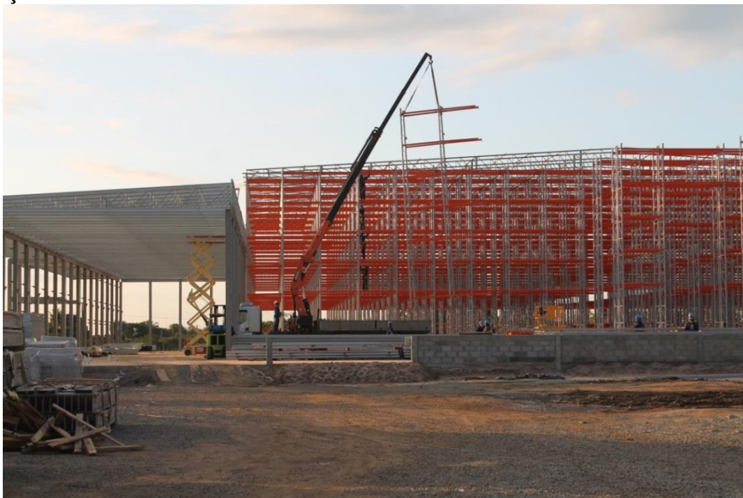
Foto 1: Instalações de futuro Centro de Distribuição da Peixoto no município de São Gonçalo – BA.
