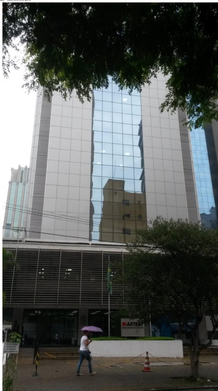
Foto 4. Prédio da ARTESP localizado na cidade de São Paulo próximo À avenida Brigadeiro Faria Lima.
