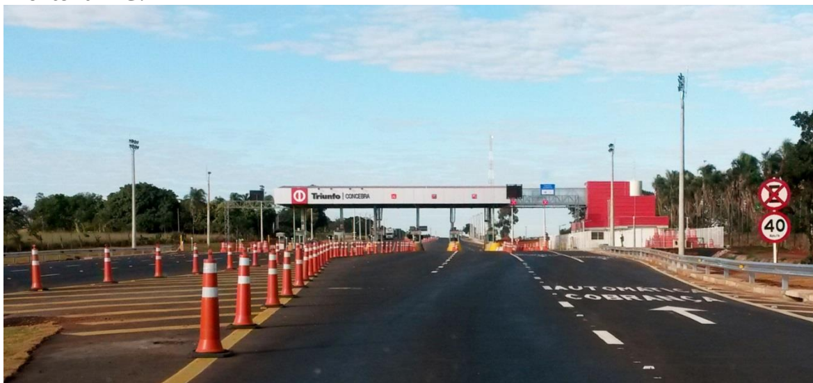
Foto 8: Praça de pedágio em construção na rodovia BR 153, no município de Fronteira MG.
