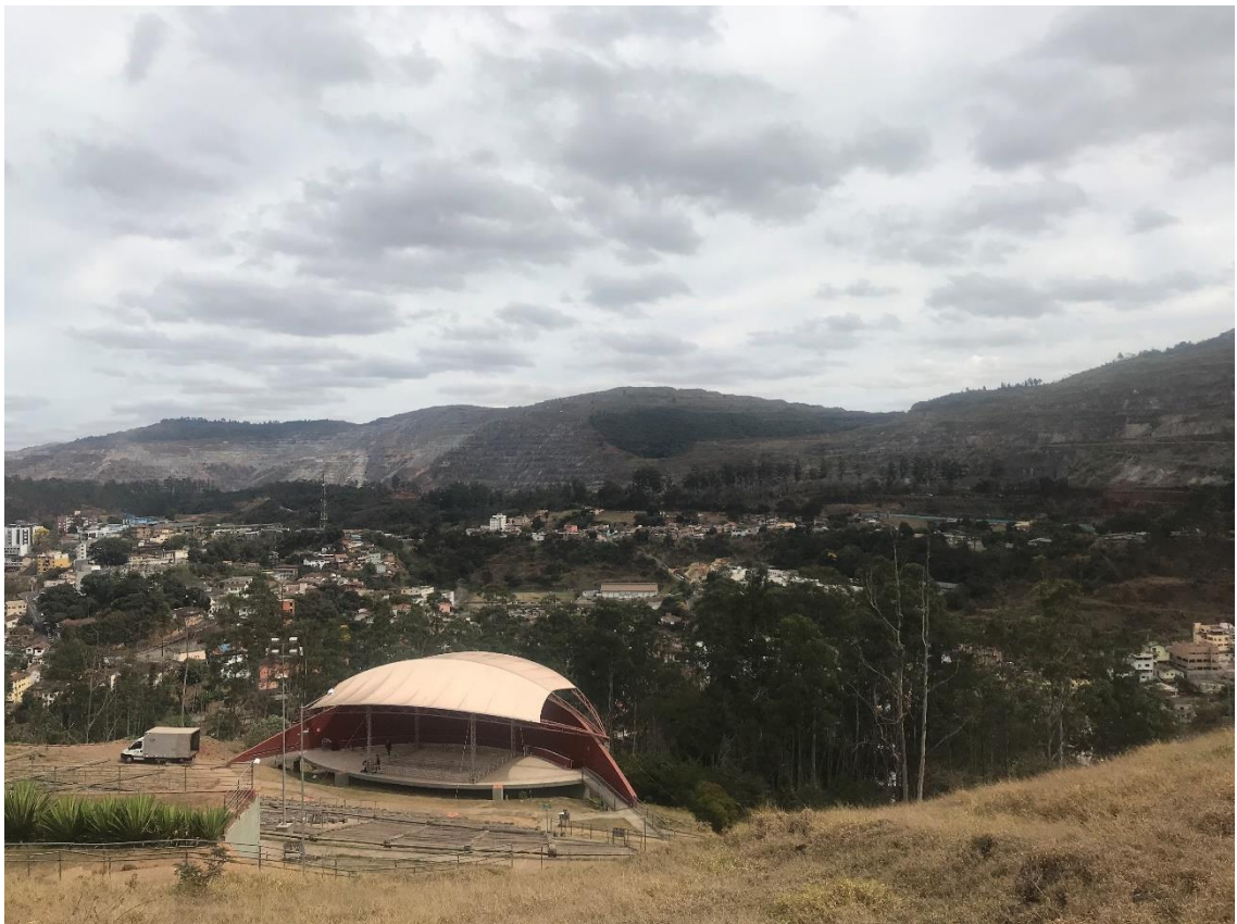
Figura 10 - Anfiteatro do memorial Carlos Drummond de Andrade com a cidade e a mina do Cauê ao fundo.
