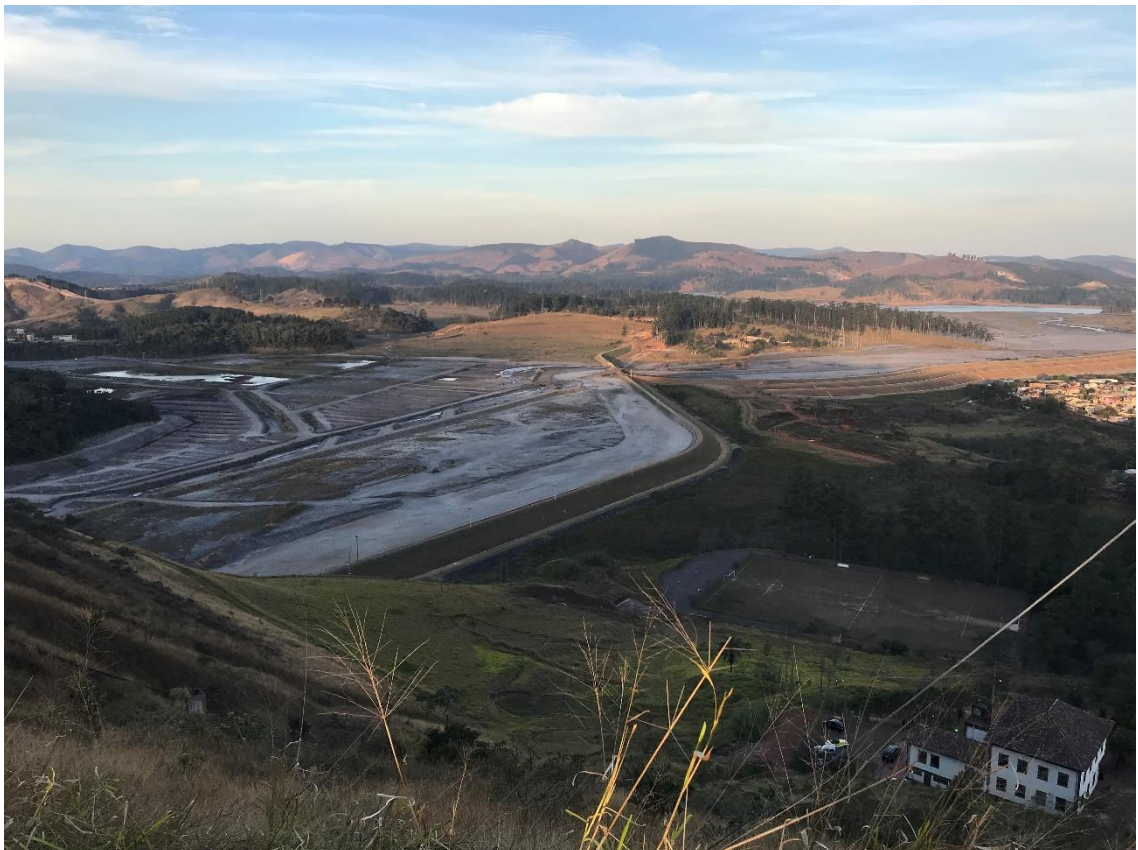
Figura 8 - Vista da barragem de rejeitos do Pontal com a casa da Fazenda do Pontal ao canto.
