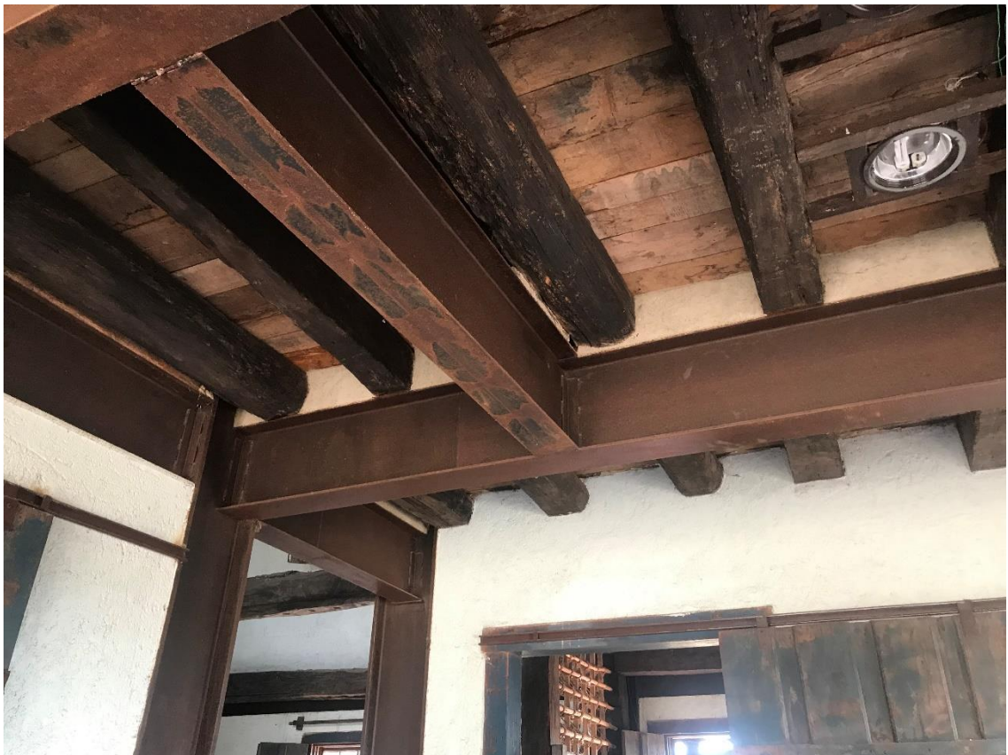
Figura 12 - Estrutura da casa da Fazenda do Pontal intercalando vigas de metal e madeira.
