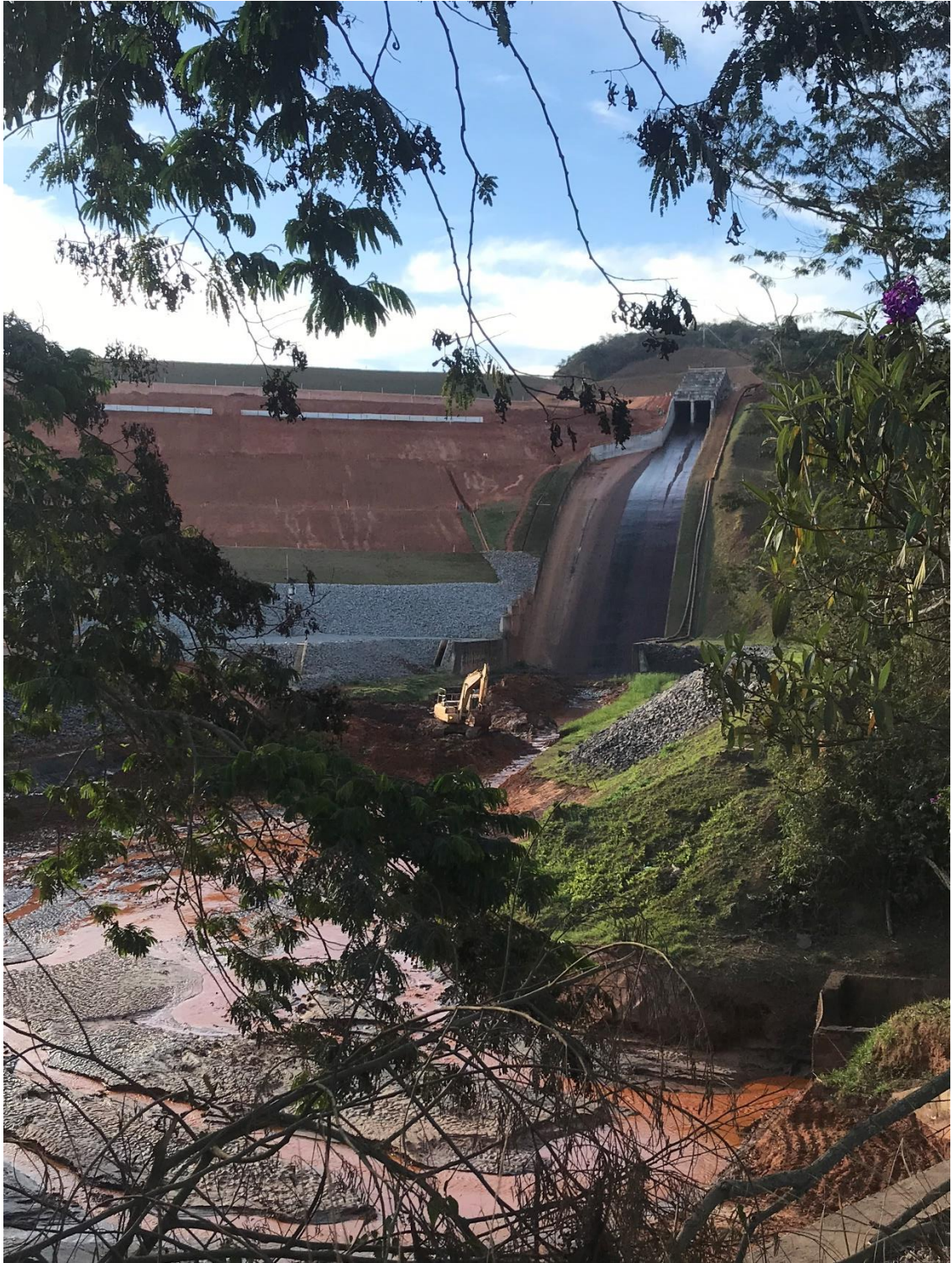
Figura 3 - Barragem da bacia de rejeitos de Itabiruçu (Itabira).
