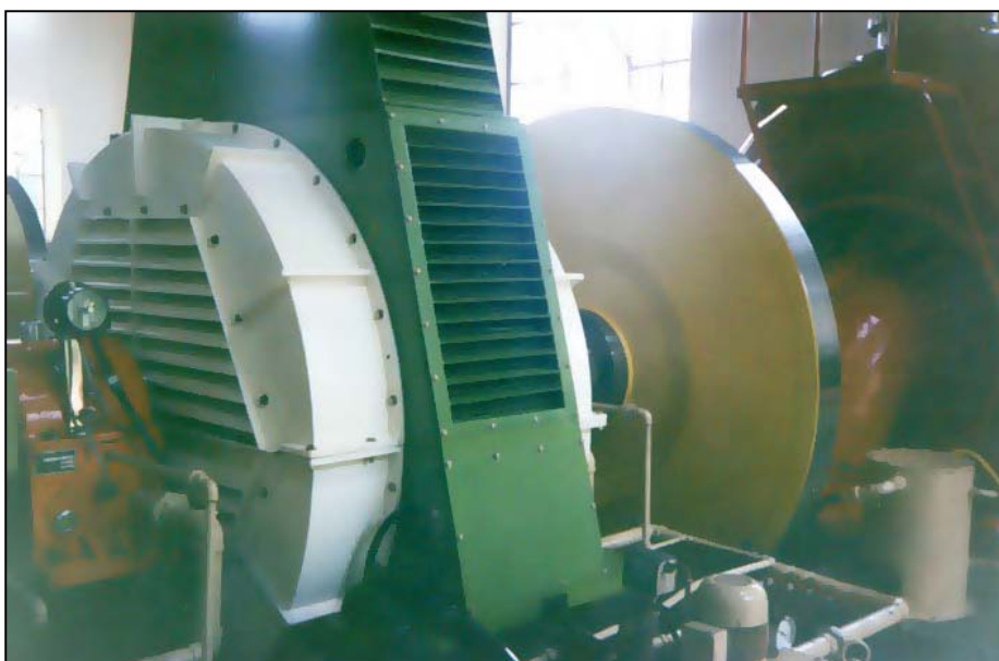
Figura 11 – Foto com destaque para o gerador de uma turbina hidráulica
