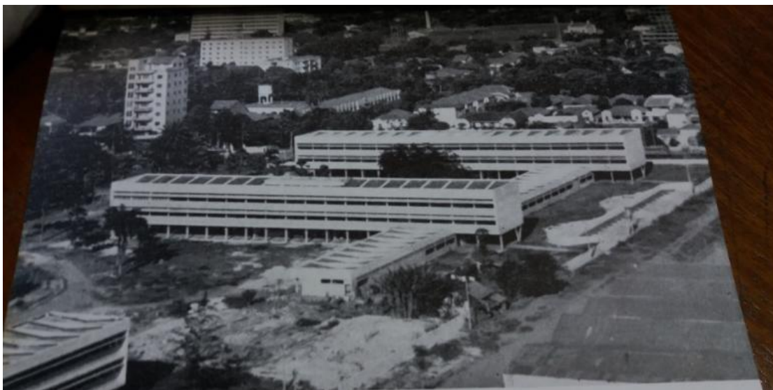
Figura 3: Instituto de Educação e Colégio Estadual de Recife
