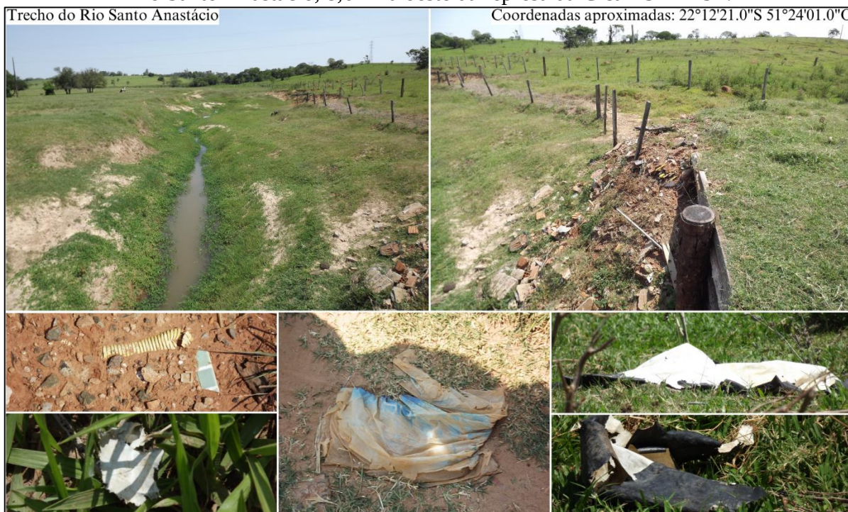
Figura 20 - Acúmulo de resíduos úrbicos e garbicos sobre ponte em estrada rural que cruza o Rio Santo Anastácio, 8,6km à oeste da represa da Cica - SABESP.
