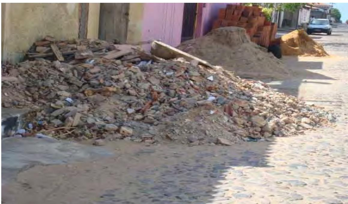
**Figura 5.4 - Obstrução da Drenagem por RCD em Parnaíba/PI**
