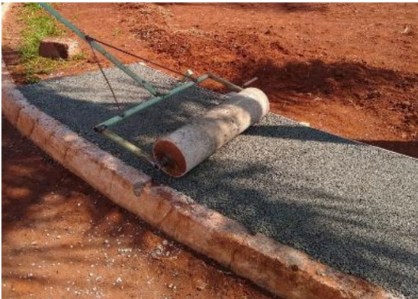
Figura 95 - Piso de concreto permeável. Fonte - Santos, 2022.
