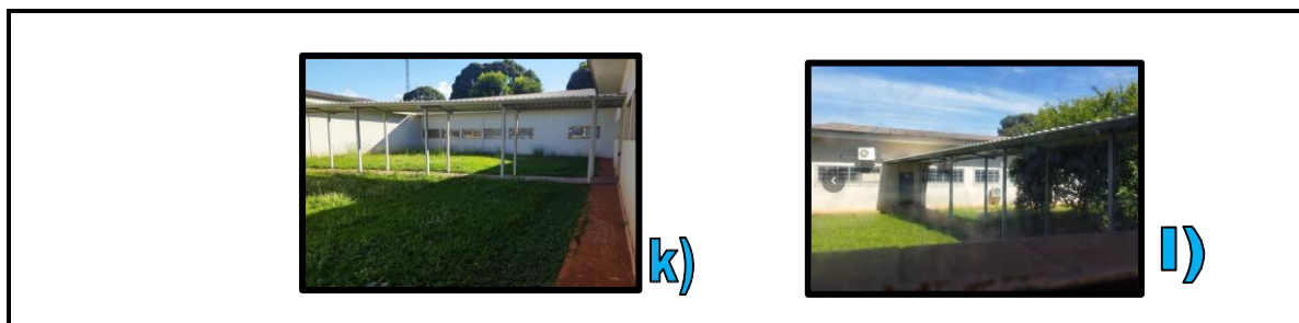
Figura 3 a, b, c, d, e, f, g, h, i, j, k, l, Patologias e análises verificadas no pavilhão.
