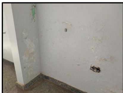
Figura 9F – Infiltração e Instalação antiga
