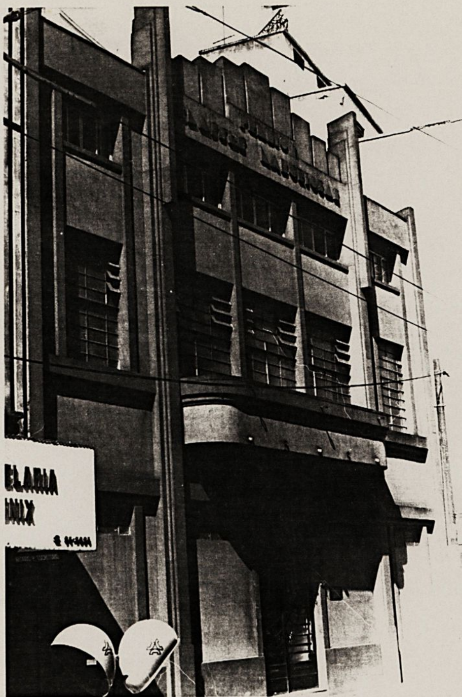
Figura 01 Prédio das Classes Laboriosas Construção em 1891. Fachada atual de 1937. Rua Roberto Simonsen, 22.
