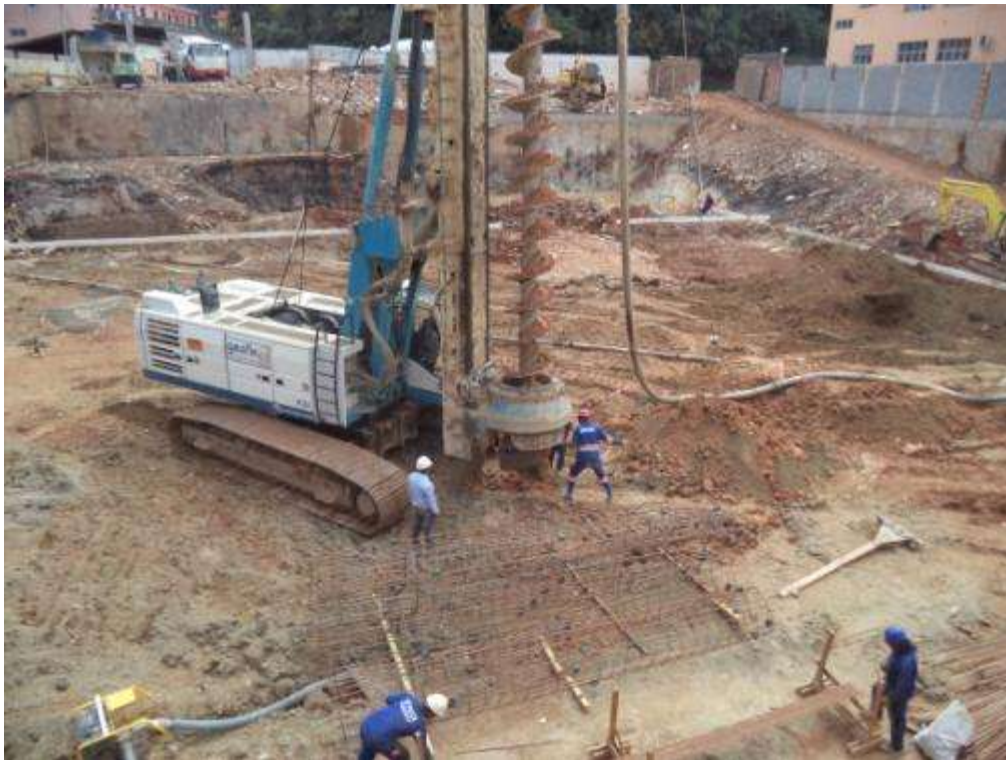
Figura 15 - Execução de estaca hélice contínua do JM 600 Office & Mall
