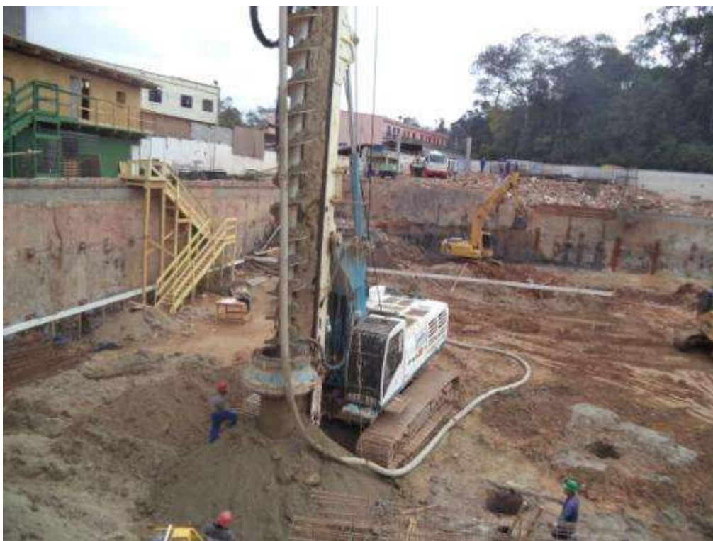
Figura 16 - Execução de estaca hélice contínua do JM 600 Office & Mall
