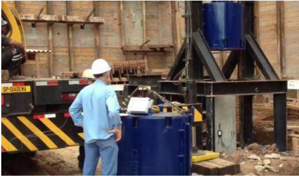
Figura 7 - Ensaio de Prova de carga dinâmica em estaca de hélice contínua
