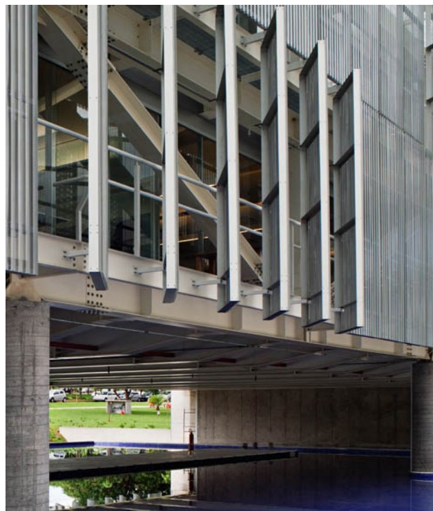
Figura 96. Exemplo de estrutura semelhante aos brises usados o projeto. Ricardo Kambara, 2011.
