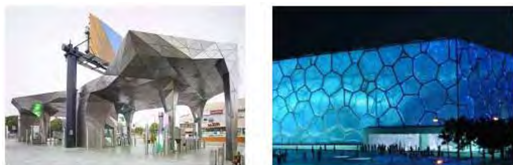
Figura 4.12: Construções arquitetônicas: Casa Helios (gas station) em Los Angeles/EUA e Parque aquático Cubo d'Água em Pequim/China.
