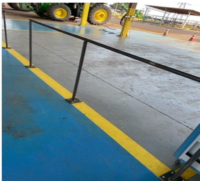
Figura 35 - Instalação de Guarda-Corpos
