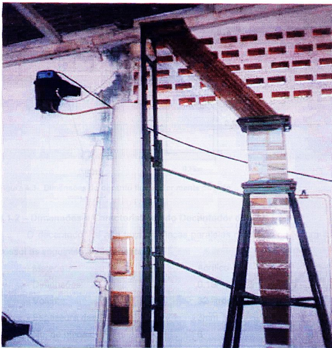
Figura 4.2 - Sistema de floculação (floculador manta de lodo), decantação (decantador de alta taxa) e filtro (filtro de areia de fluxo descendente) utilizado na realização dos experimentos – detalhe para a medição contínua da turbidez na saída do decantador
