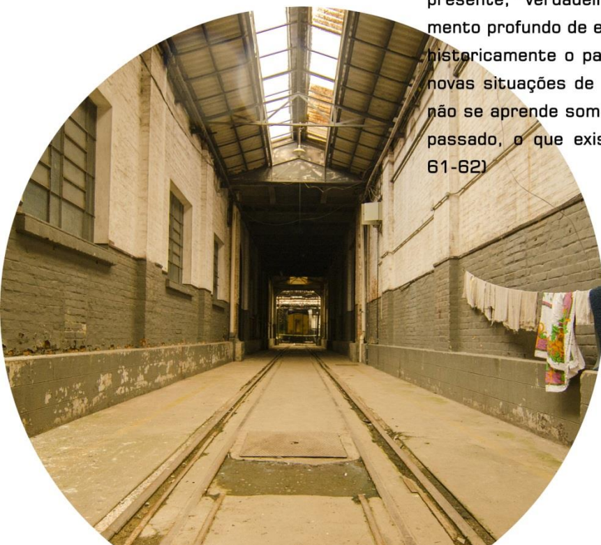
FIGURA 46 > Trilho de desvio interno do Complexo FONTE > Acervo fotográfico do autor
