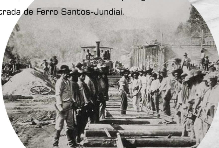
FIGURA 11 > Construção da Ferrovia em Jundiaí FONTE > Museu da Companhia Paulista
