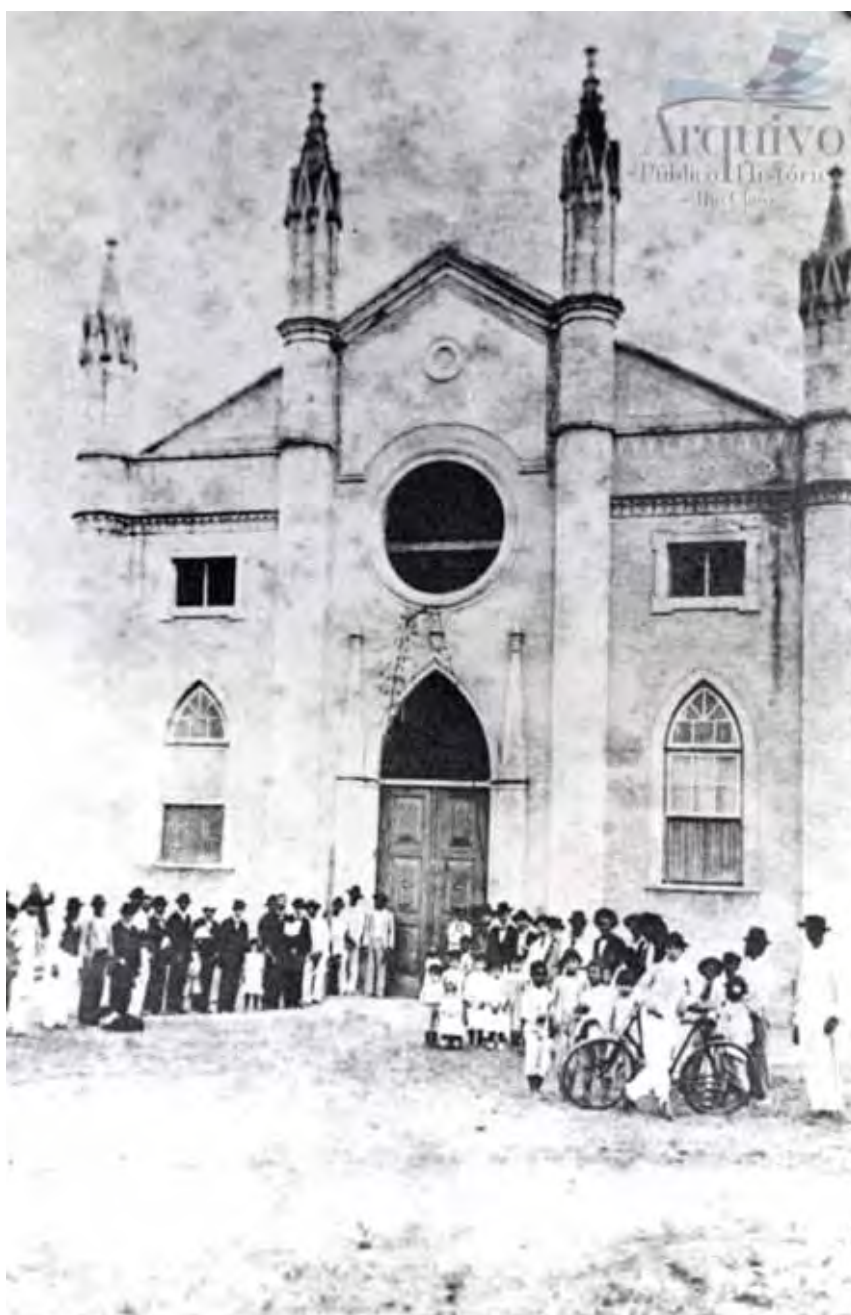
Foto 10 - Igreja de São Benedito em construção 1901 Arquivo Histórico de Rio Claro
