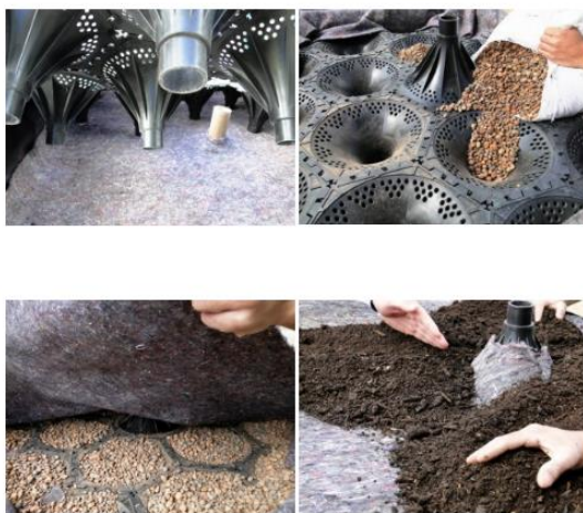
Figura 40: Preenchimento dos cones com argila verde e montagem do piso elevado.
