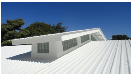
Figura 24: Iluminação zenital (lanternim).
