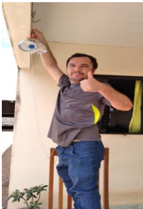
Figura 23: Instalação do amostrador no local Casa. Fonte: Autor.
