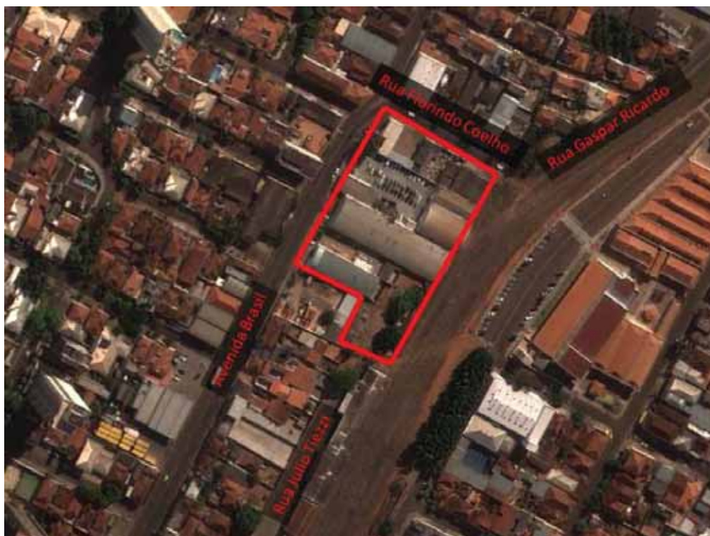
Figura 2 - Área de Intervenção Fonte: Google Earth
