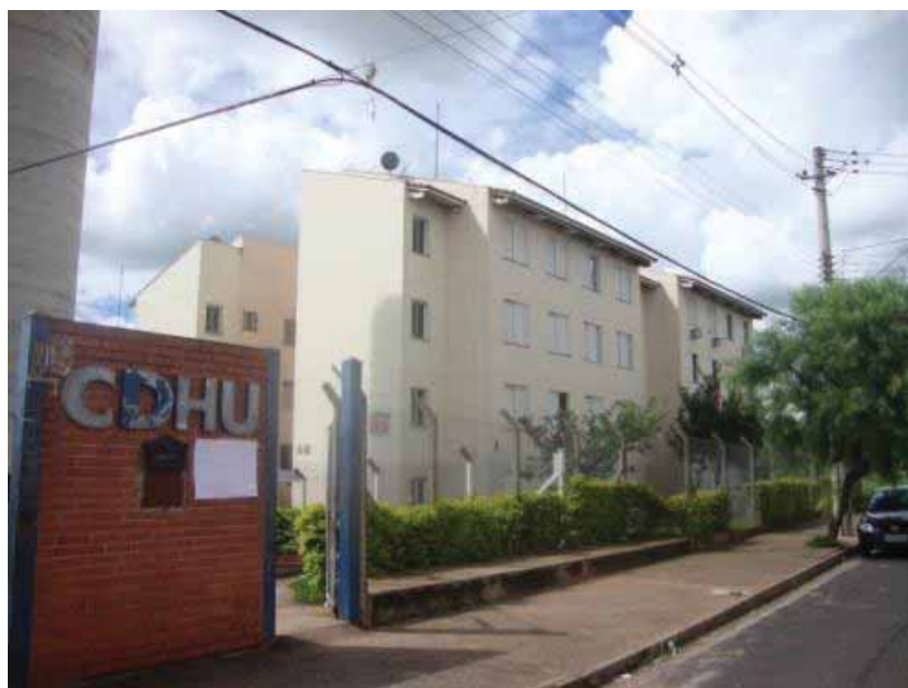
Figura 34 - Fachada do Conjunto K Fonte: PEZATTI, B.L.
