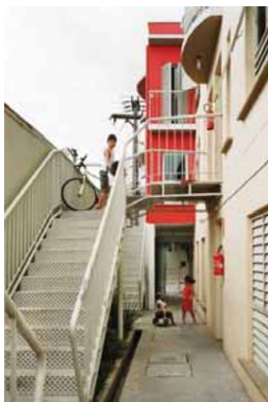
Figura 23 - Acesso dos duplex feitos por escadas. Fonte: Revista A.U. Ano 24, Nº 186, set. 2009
