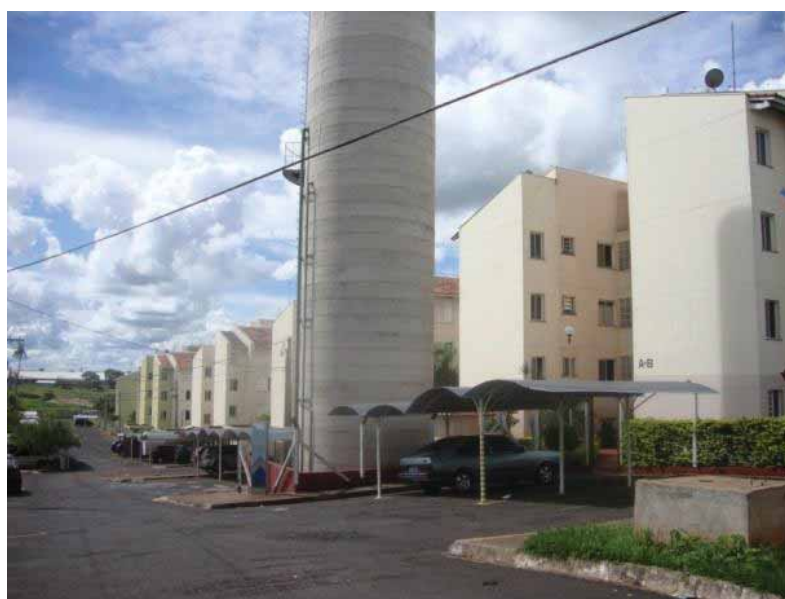
Figura 35 - Vista Lateral do Conjunto K Fonte: PEZATTI, B.L.
