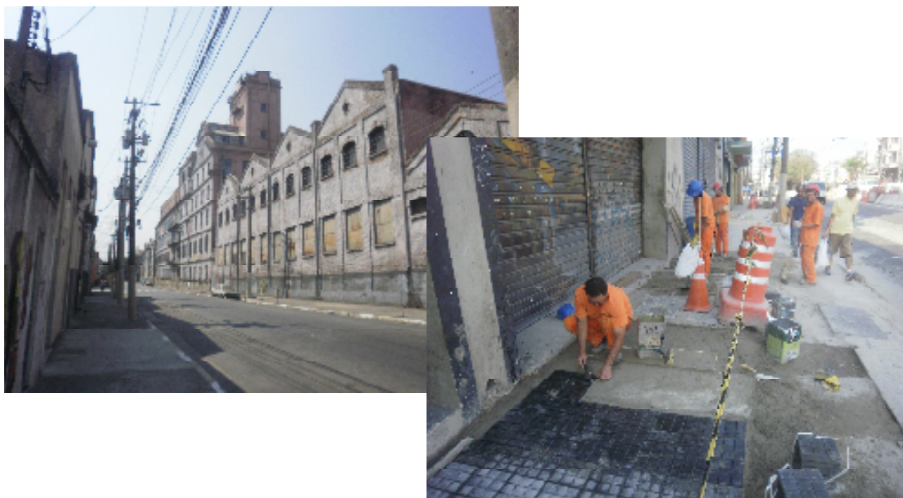
(Foto 22: Antigo Moinho Matarazzo. Foto 23: Obras de recalçamento da Rua do Gasômetro. Própria Autoria, 2012)
