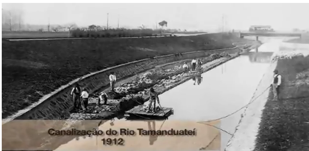
(Foto 1 - Rio Tamanduateí sendo canalizado, em 1912. SANTA MADEIRA, 2011)
