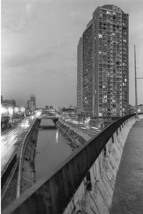
(Foto 5: Edifício São Vito. Cristiano Mascaro, 2003)
