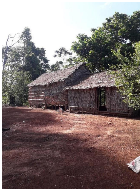
Figura 5: Residência de palha na comunidade Boa Esperança, interior da REBIO.
