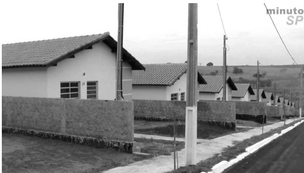
Figura 10: Obras concluídas do conjunto habitacional Parque das Flores (2013)
