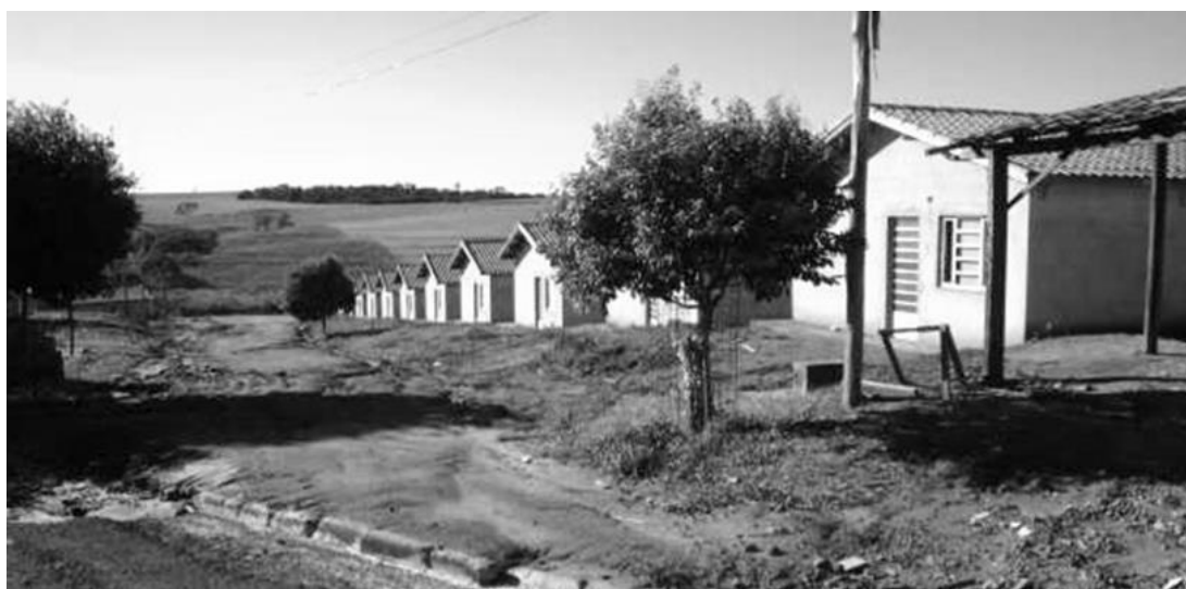
Figura 8: Conjunto habitacional em fase de construção (fotografia registrada em 2012). Fonte: MACHADO, 2014.: Compõe o material etnográfico da pesquisa/Fotografia do próprio autor.
