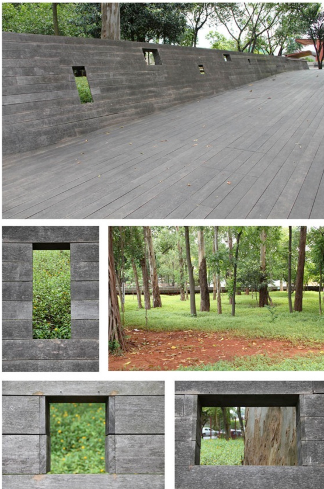
Fig. 30. Vistas das janelas da rampa do deck.
