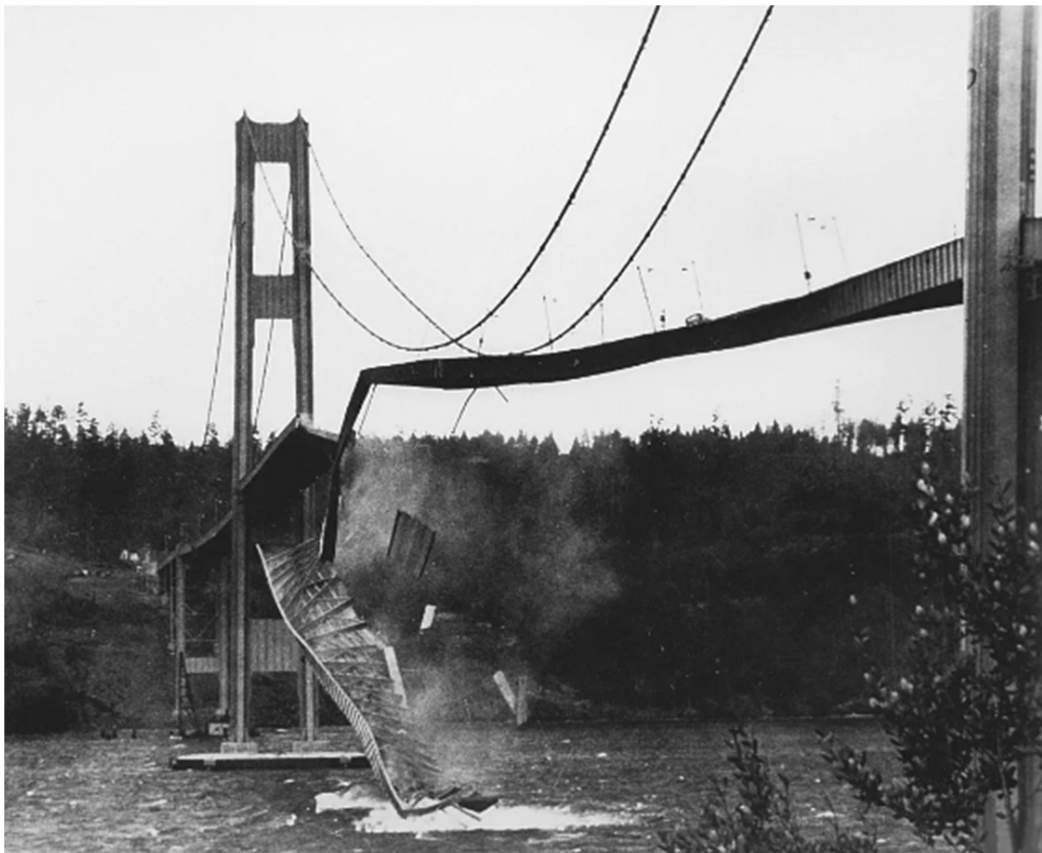
Figura 1 – Ponte Tacoma Narrows entrando em colapso por ressonância.
