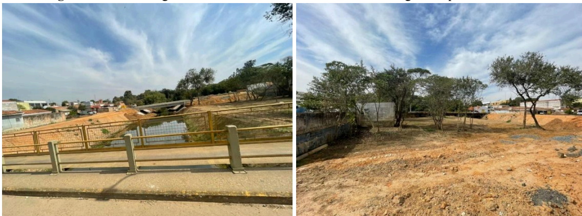
Figuras 65 e 66. Imagens da área desmatada e desassoreada na região da ponte da Rua XV
