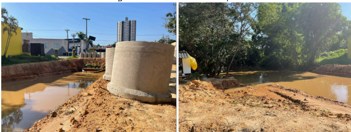
Figuras 69 e 70. Obras de canalização no centro da cidade
