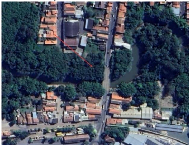
Figura 63. Ponto de destaque na rua XV de novembro, área afetada pelas inundações
