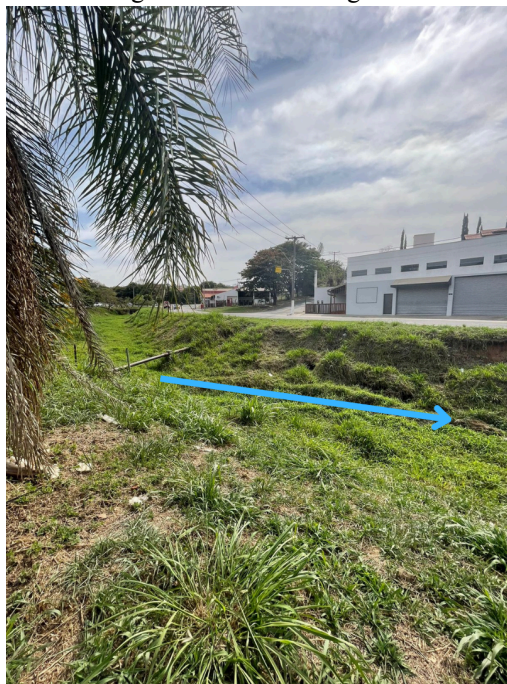
Figura 35. Fotografia de canal na região norte da cidade
