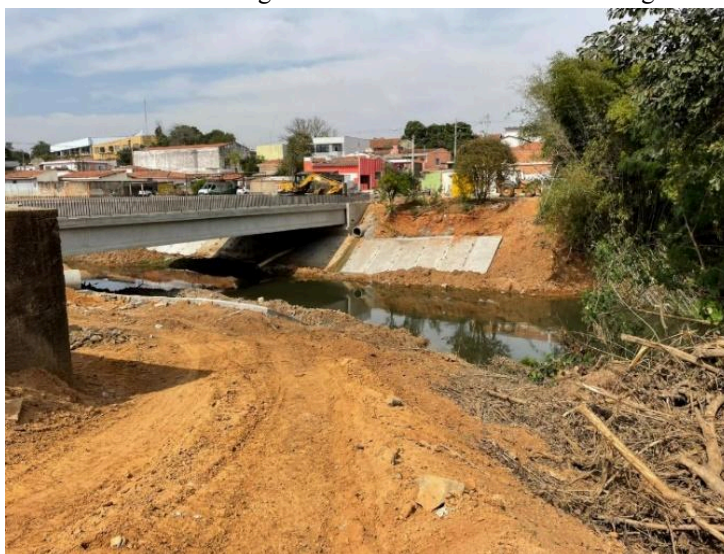
Figura 67. Área com concretagem de cabeceiras e saídas de drenagem canalizada
