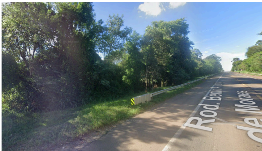
Figura 77. Imagem do Street View de 2024 com área da rodovia SP-101 com área de ruptura artificial
