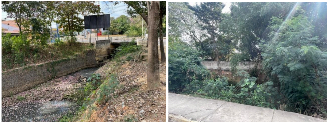
Figuras 84 e 85. Canalização do córrego Lava-Pés
