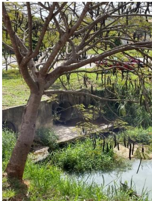
Figura 37. Fotografia de saída de canalização no córrego Chiquinho Quadros
