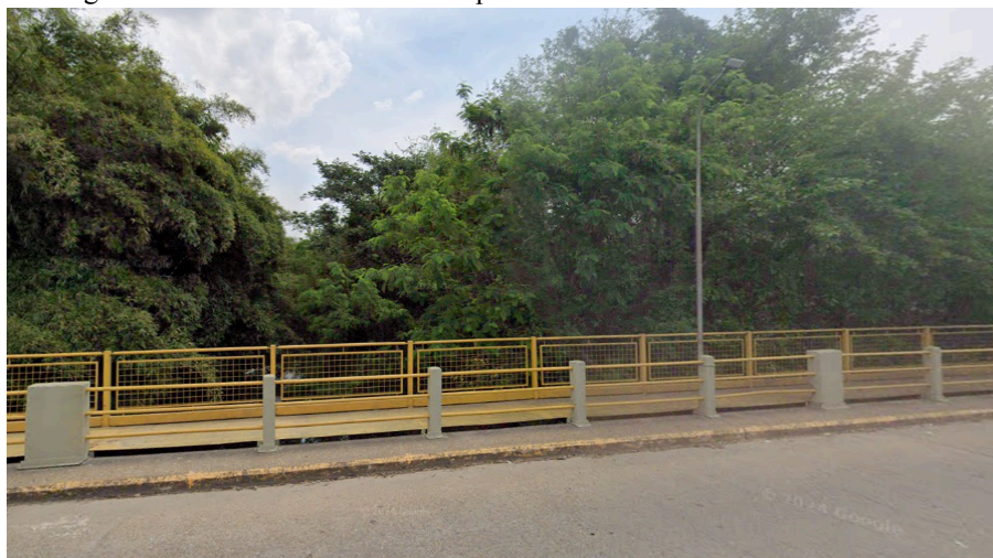
Figura 64. Imagem do Street View mostrando a ponte da Rua XV antes das obras de desassoreamento
