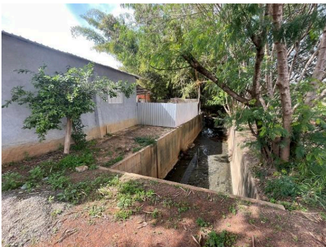
Figura 45. Casa próxima a canal canalizado
