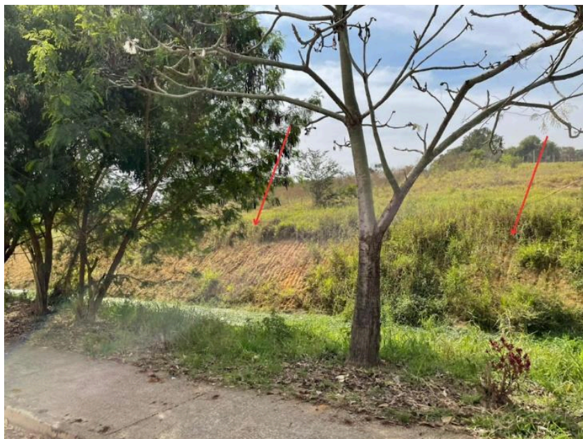
Figura 83. Marcas do desassoreamento no córrego
