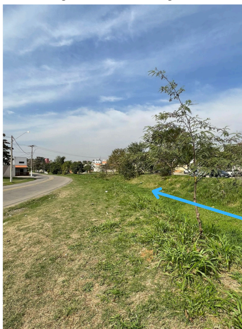
Figura 36. Fotografia de canal na região norte da cidade
