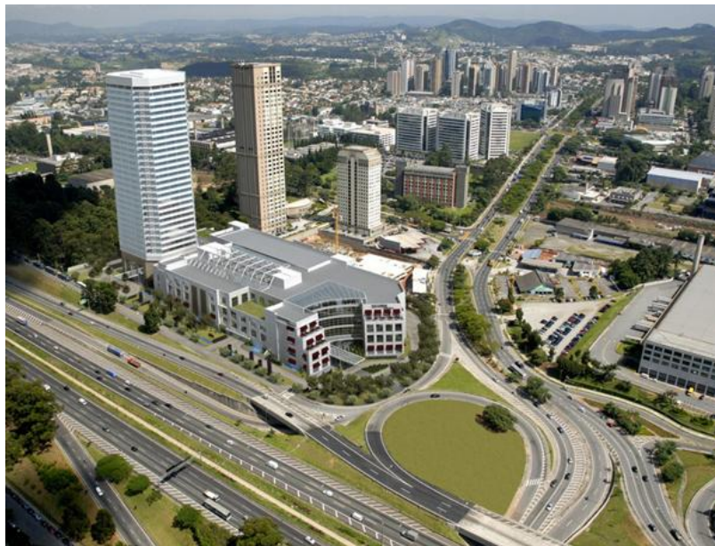
Figura 4 – Vista aérea da Rodovia Castelo Branco na entrada do bairro de Alphaville
