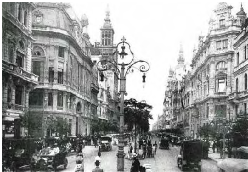
Ilustração 18: Avenida Central (s.a.).
