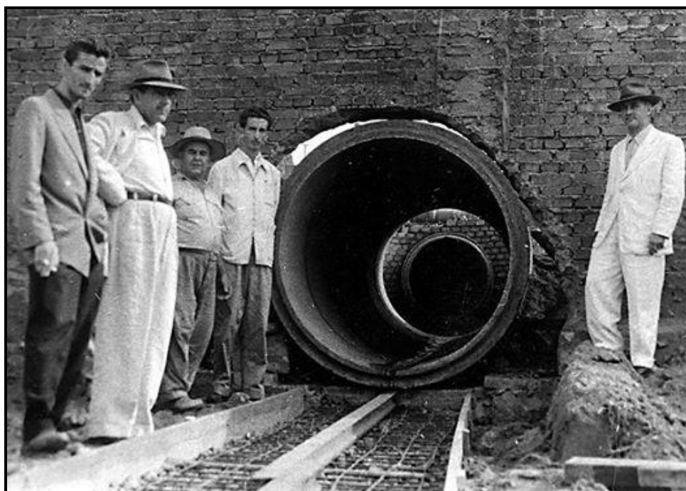
Figura 18- Construção do Ponto de Drenagem Fonte: Cidadania em Assis
