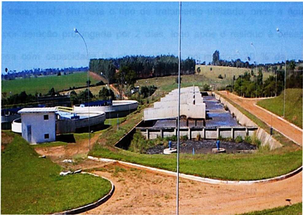
Figura 4. Vista da Estação de tratamento de Esgoto de Araçatuba.
