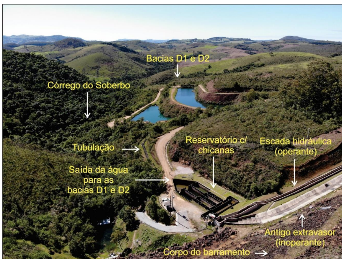
Figura 23: Disposição das estruturas hidráulicas no barramento e o ponto de liberação de águas com radioisótopos para as bacias D1 e D2.
