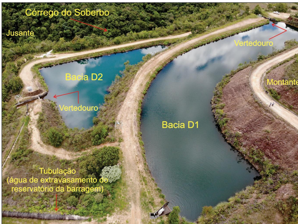
Figura 22: Imagem aérea das bacias de contenção de águas ácidas da MOU.
