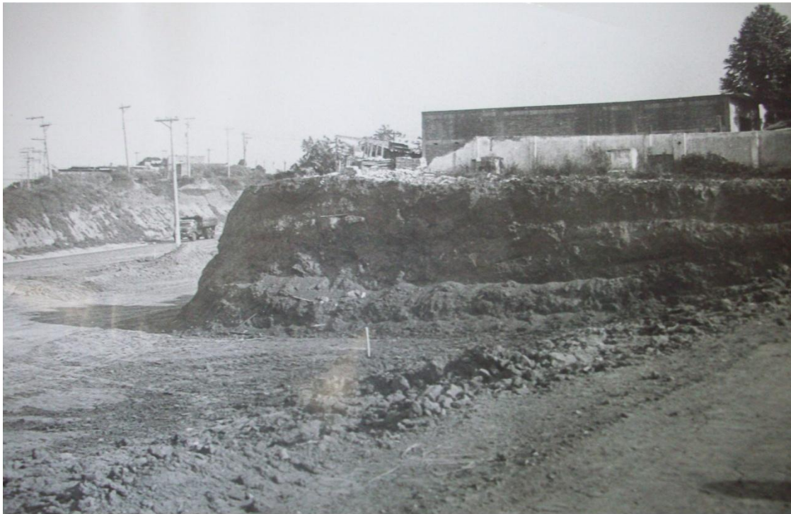
Figura 12 – Execução da terraplanagem para a construção do aeroporto. Fonte: Arquivo Histórico Municipal de Guarulhos – Década de 1980.
