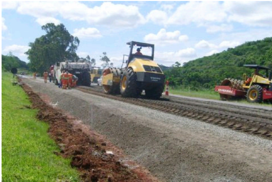
Figura 2. Equipamentos executando a compactação de um tipo qualquer de base.
