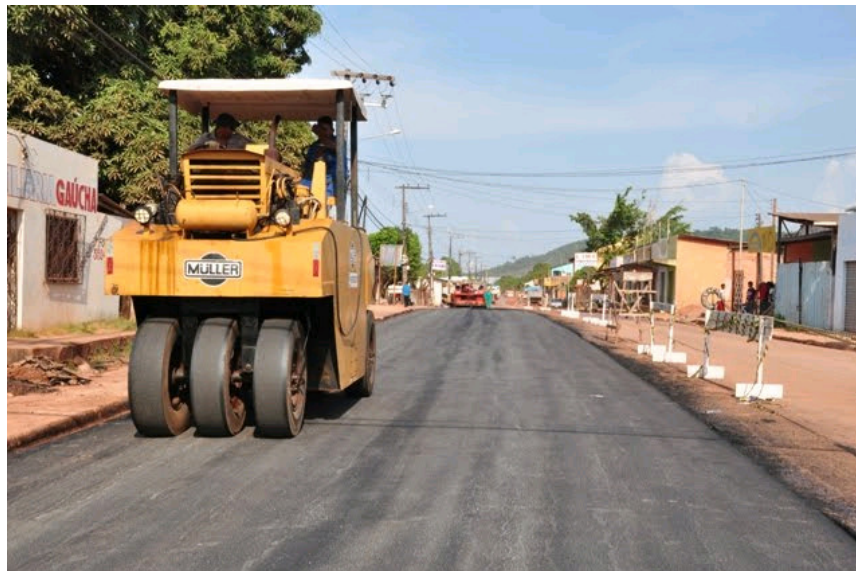
Figura 3. Execução de revestimento asfáltico.
