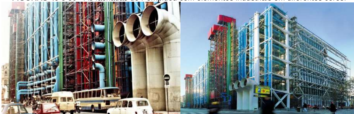
FIGURAS 49 e 50 - As fachadas do Pompidou com elementos industriais em diferentes cores.
