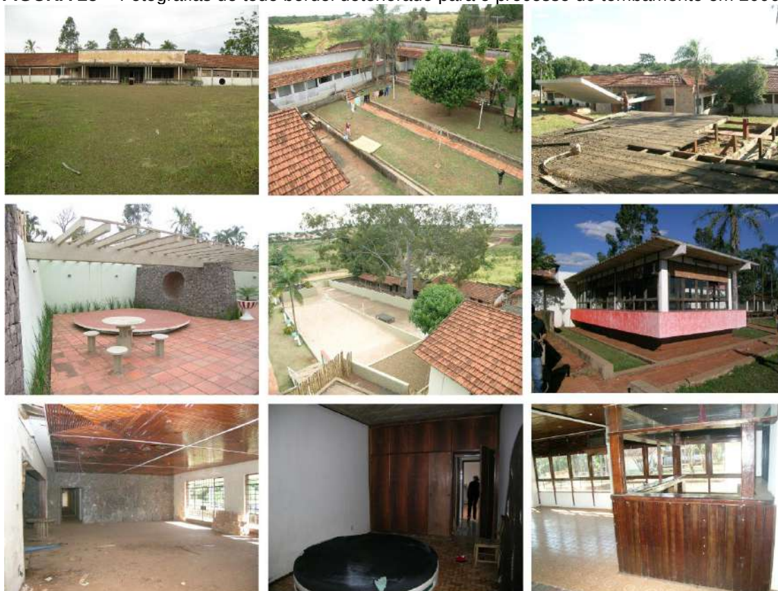
FIGURA 25 - Fotografias de todo bordel deteriorado para o processo de tombamento em 2006.
