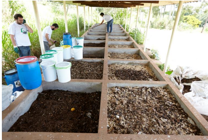
Foto 8. Baias de concreto de 1m 3 cada utilizadas para a compostagem
