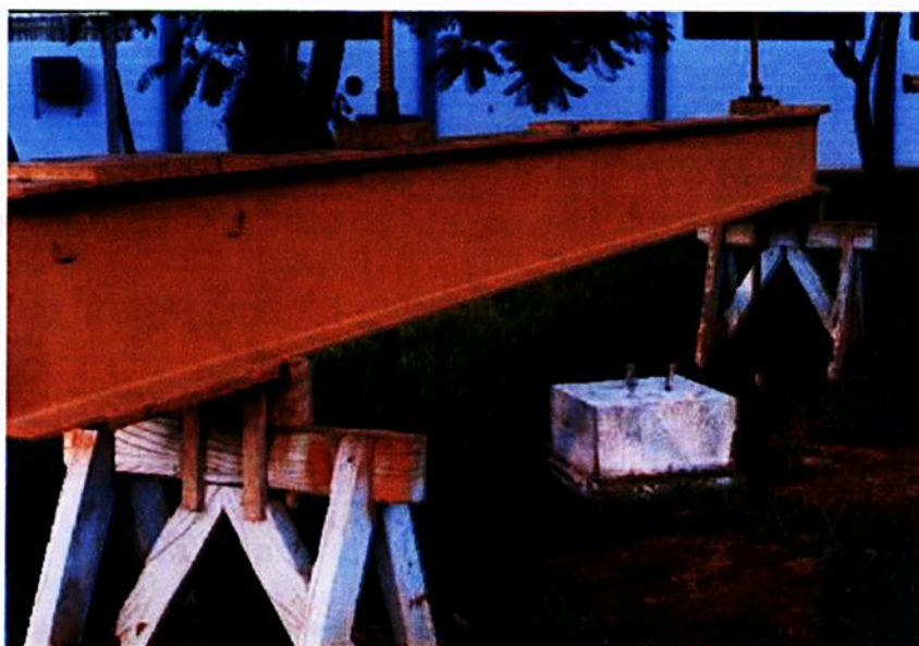
Figura 4.9 – Viga de reação
