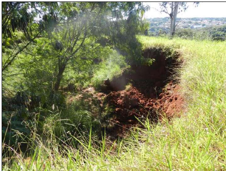
Foto 10. Processo erosivo agressivo formado pelo rompimento da bacia de retenção.
