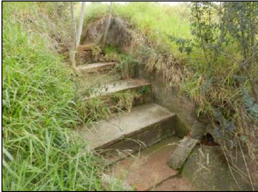
Foto 11. Dissipador comprometido.
