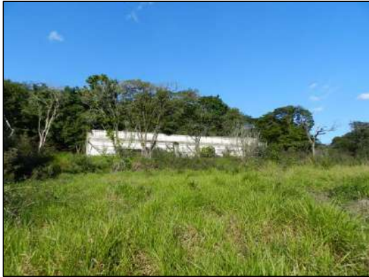
Foto 2. Ruínas de antiga empresa na ARIE.
