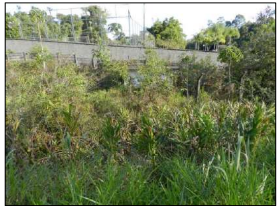
Foto 5. Muro de divisa junto ao córrego.
