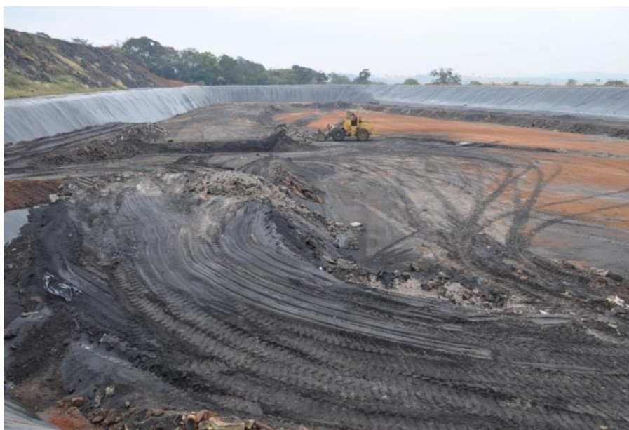
Figura 2: Aterro industrial licenciado
