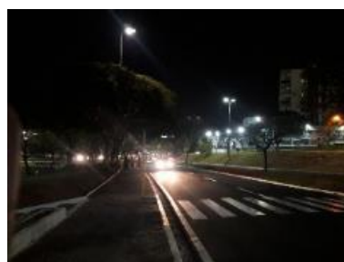
Figura 96 - Iluminação na Av. Nações Unidas.
