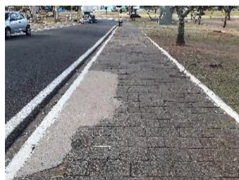
Figura 78 - Preenchimento de pisos com material diferente na rua Praça Vitória Régia.
