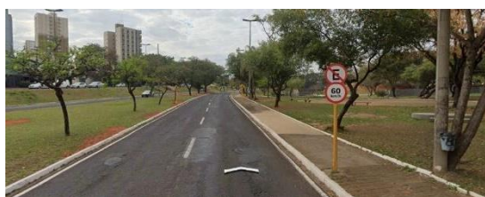
Figura 102 - Placas de sinalização vertical na Av. Nações Unidas.
