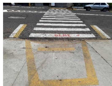
Figura 87 - Rampa de acessibilidade na calçada do parque – Rua Antônio José Miziara.
