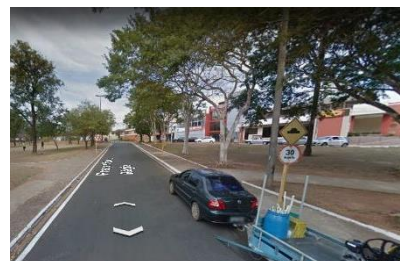
Figura 101 - Placas de sinalização vertical Rua Praça Vitória Régia.
