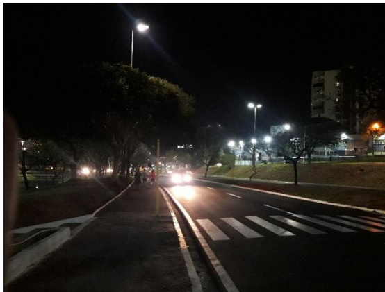
Figura 18 - Iluminação na Av. Nações Unidas.
