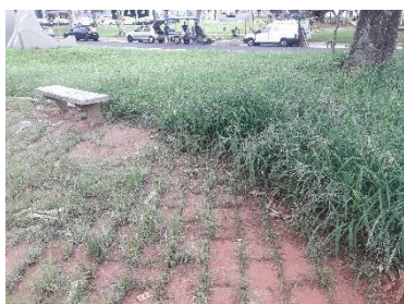
Figura 111 - Bancos antigos sem manutenção.
