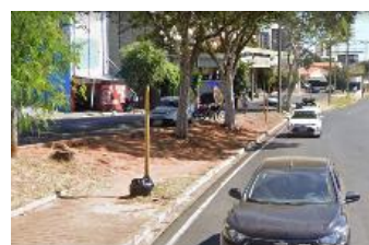
Figura 85 - Desnível em relação à rua Praça José Miziara e Av. Nações Unidas.
