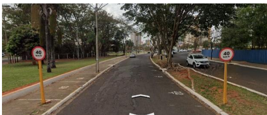
Figura 100 - Placas de sinalização vertical Rua Praça Antônio José Miziara.
