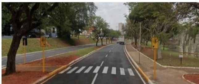
Figura 99 - Sinalização vertical de travessia na Av. Nações Unidas.
