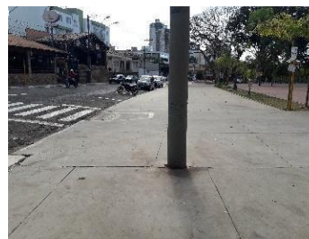
Figura 81 - Poste no meio da calçada do parque da Rua Antônio José Miziara.
