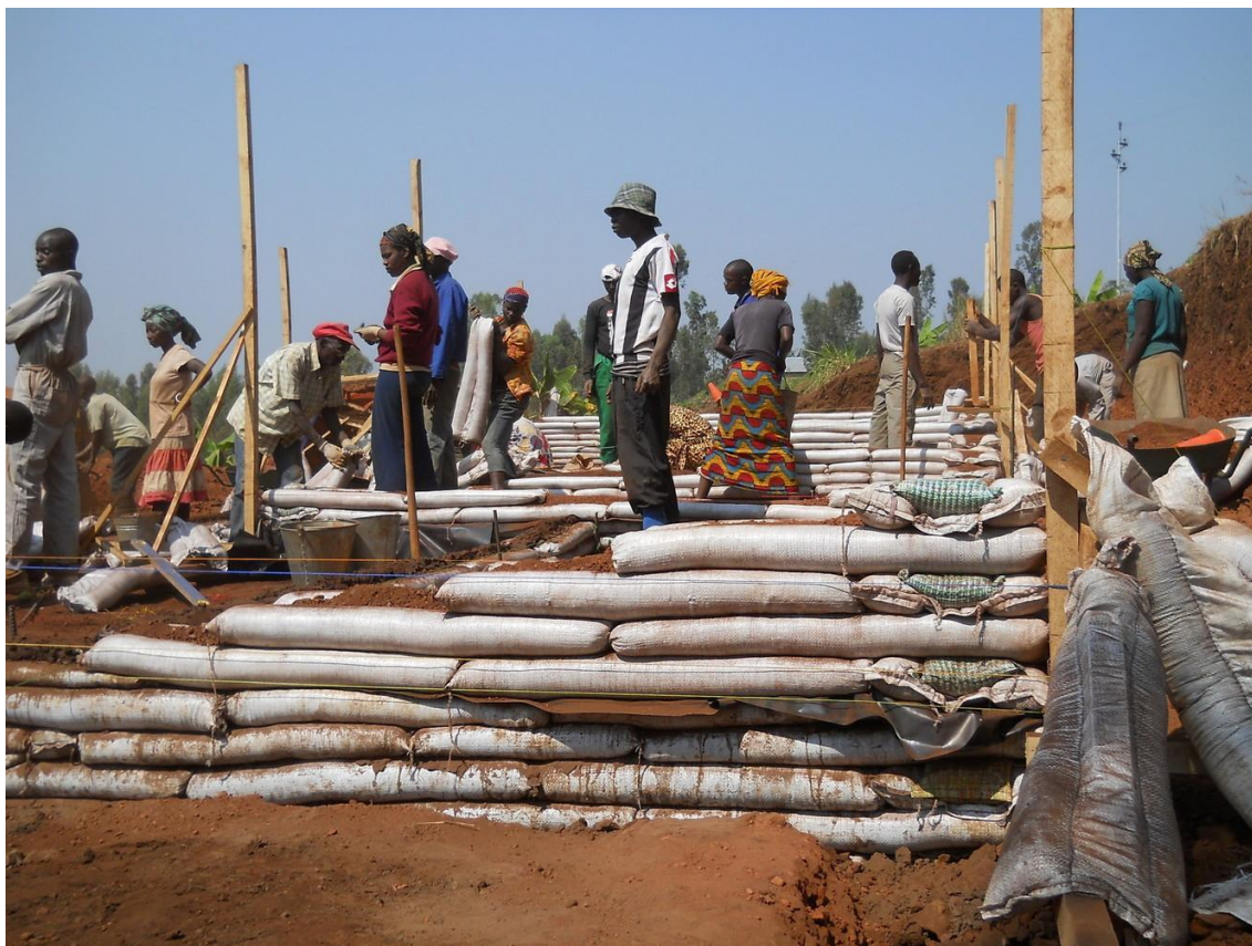
Figura 10: Estrutura de superadobe sendo levantada
