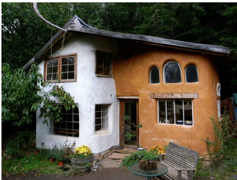
Figura 11: Casa feita de Cob
