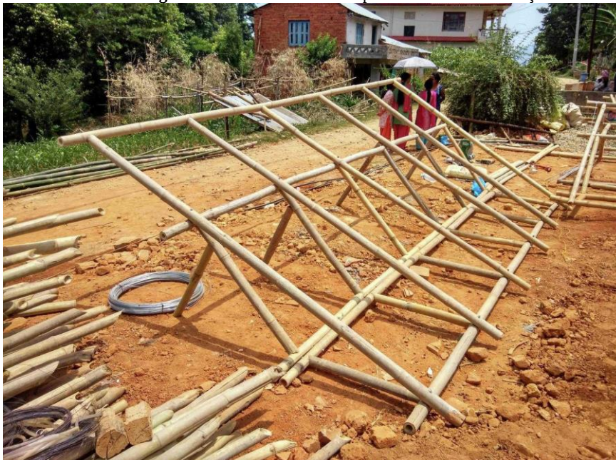
Figura 13: Estrutura de bambu para cobertura de habitação
