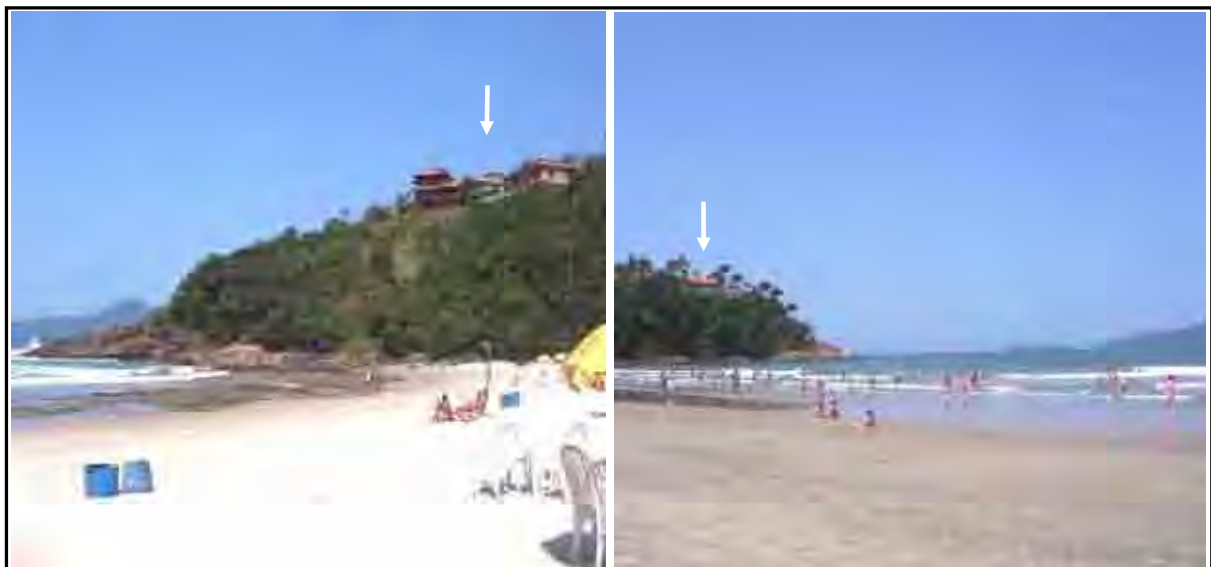
Figura 8 – ocupações irregulares (em destaque) nos esporões do Litoral Norte (Ubatuba). Imagem e org: ROSEGHINI, W. F. F. Fonte: trabalho de campo, setembro/2005.
