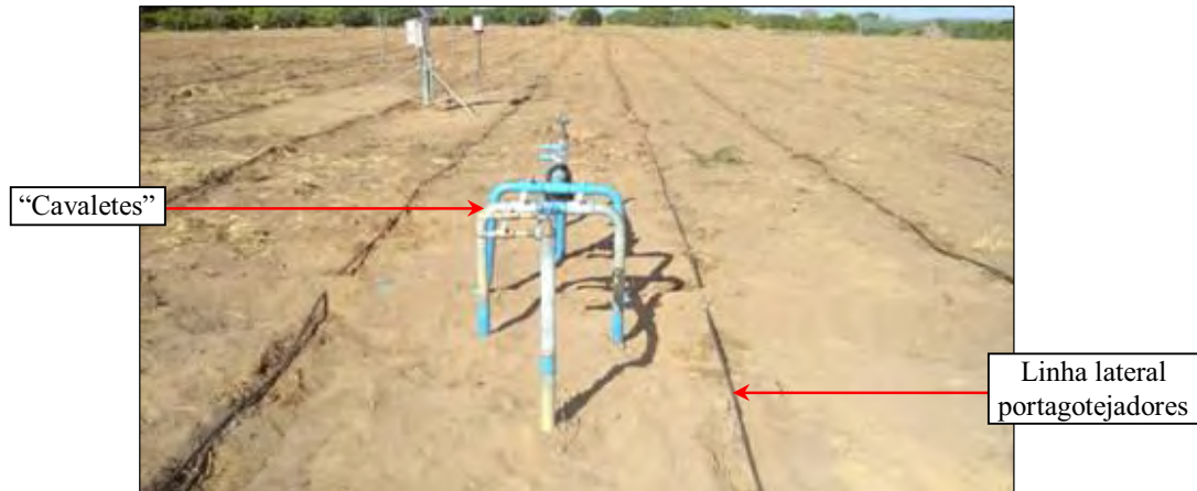
Figura 4. Linhas laterais portagotejadores e “cavaletes” com registros de controle da vazão.
