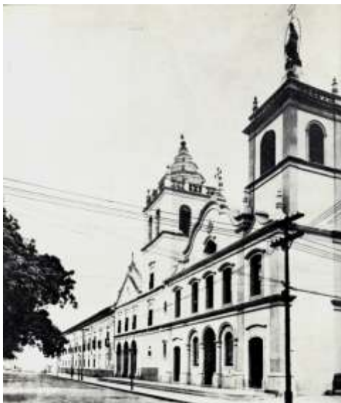
Figura 270. Conjunto do Carmo com a nova torre da Igreja da Ordem Terceira, 1912.
