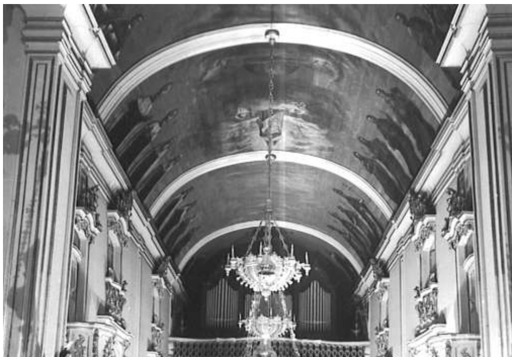
Figura 271. Teto da nave da Igreja da Ordem Terceira do Carmo, em 1942, anterior às intervenções de J. Schulte. Fotografia de H. Graeser. Acervo do IPHAN.
