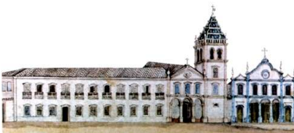
Figura 268. Conjunto do Carmo (1847). Aquarela de Miguel Dutra.
