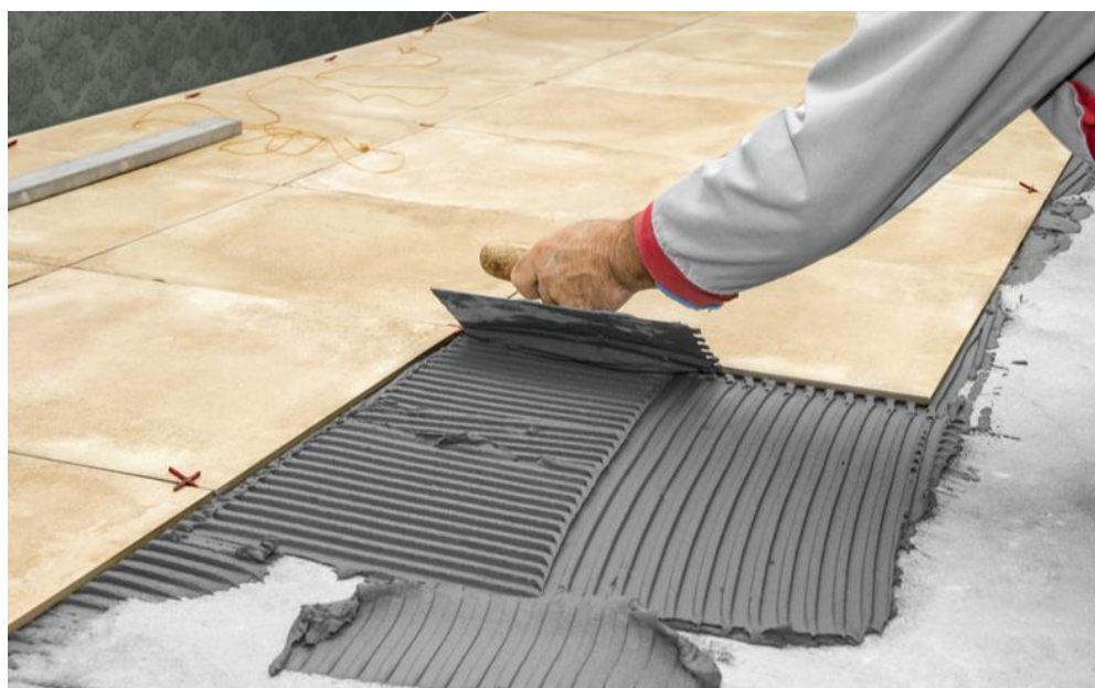
Figura 14: Assentamento cerâmico.
