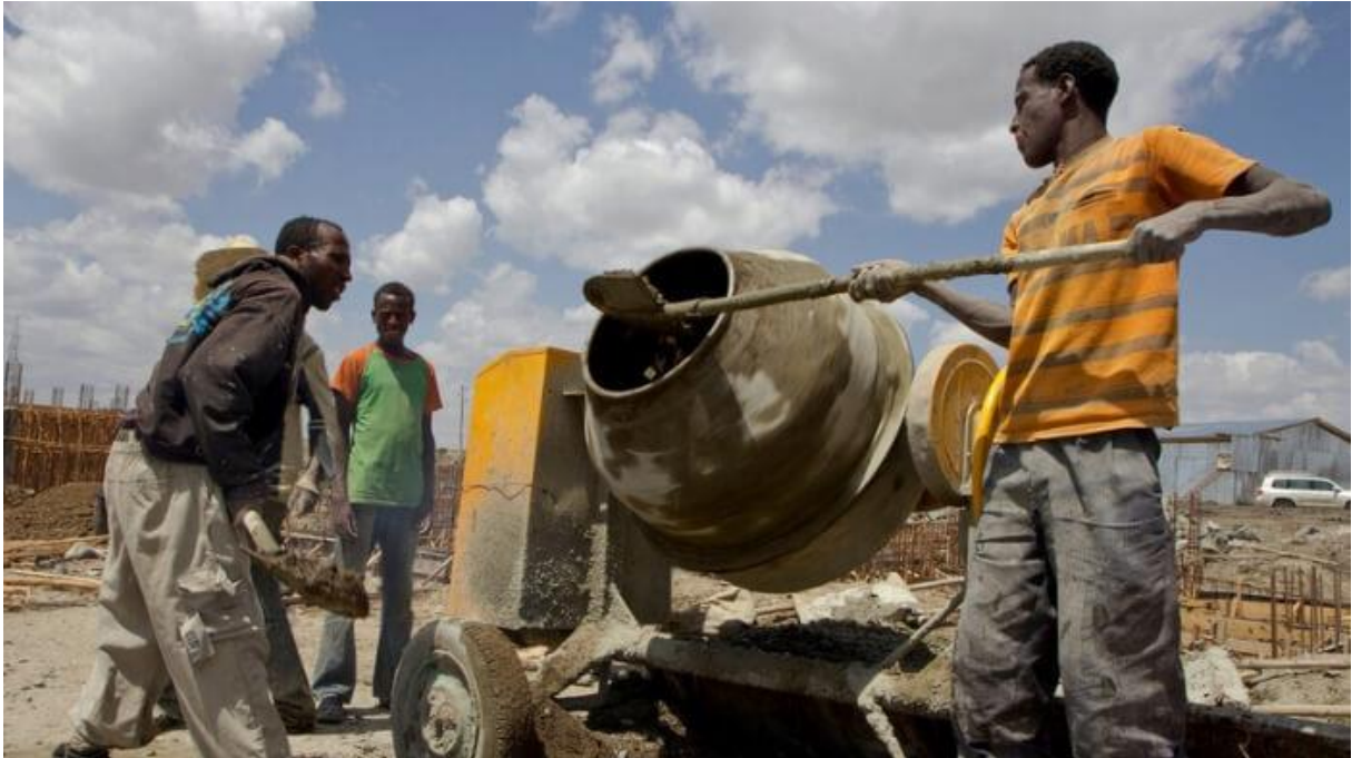
Figura 5: Argamassa produzida em obra.
