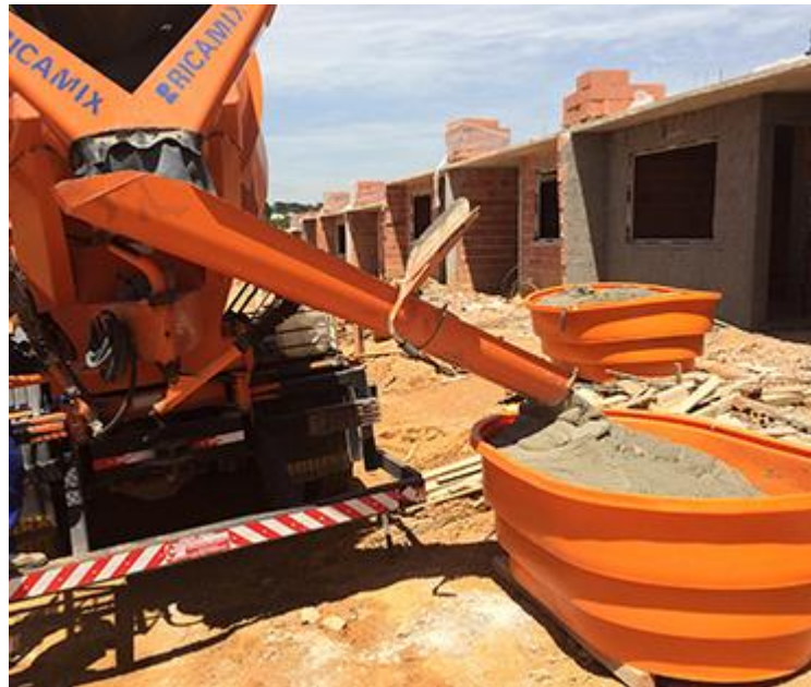
Figura 10: Descarregamento de argamassa estabilizada.
