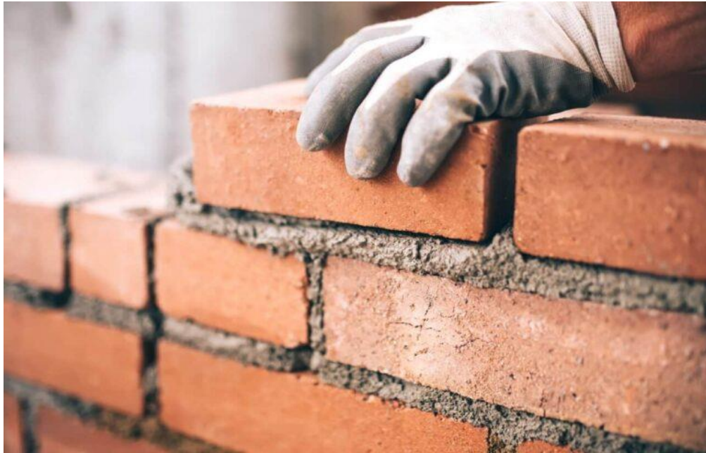
Figura 11: Argamassa de assentamento.
