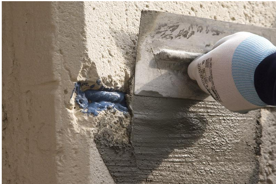
Figura 15: Argamassa de reparo.
